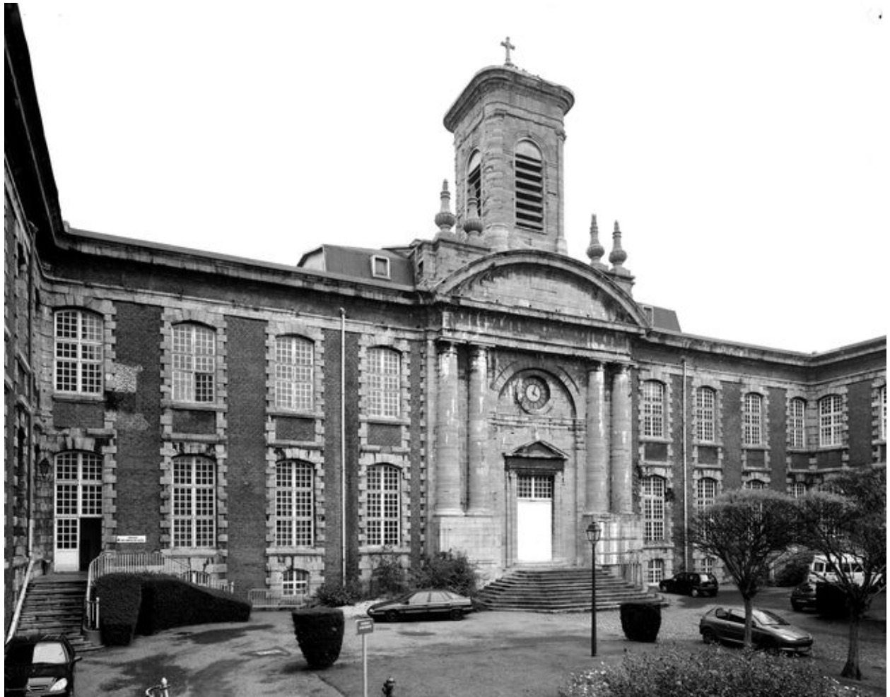
Ancien hôpital général de Valenciennes.
