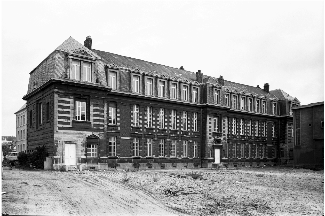
Vue d'angle sud-ouest.
