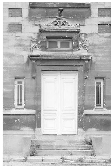
Façade sud-ouest, porte.
