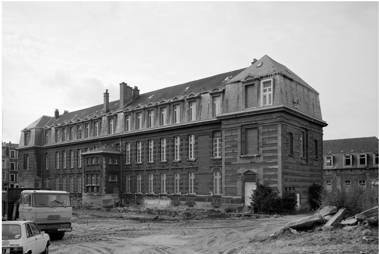
Vue d'angle nord.
