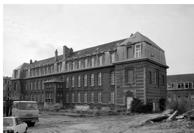
Vue d'angle nord.
