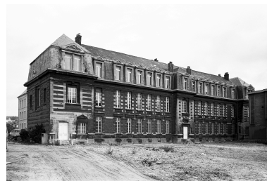
Vue d'angle sud-ouest.
