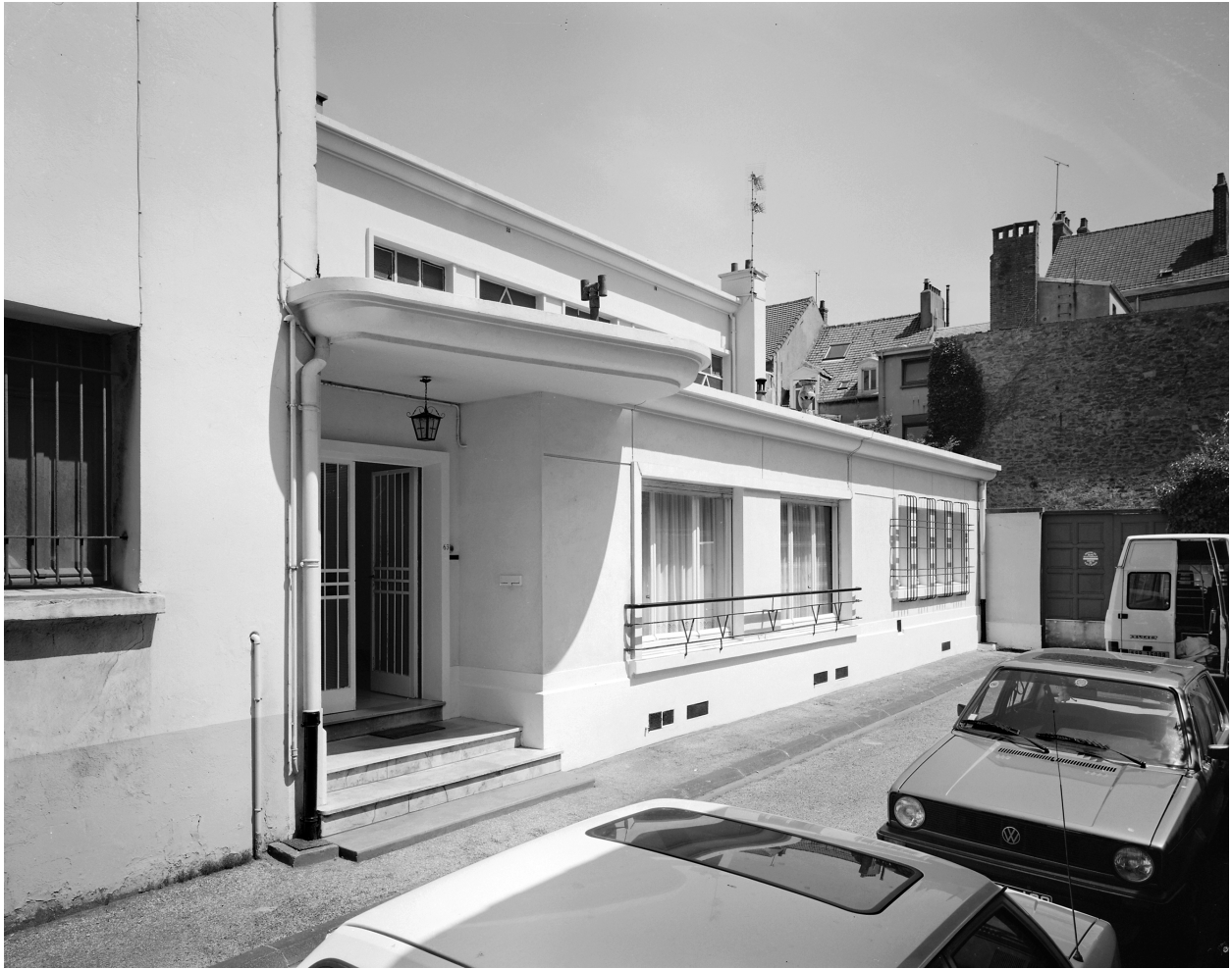
Synagogue, vue d'angle sur voie.
