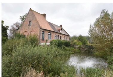
Vue générale de la ferme depuis le sud-ouest. Phot. Delphine Volto Jourdan IVR32_20245903199NUCA
