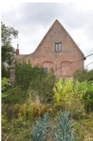
Détail du pignon ouest. Phot. Delphine Volto Jourdan IVR32_20245903198NUCA
