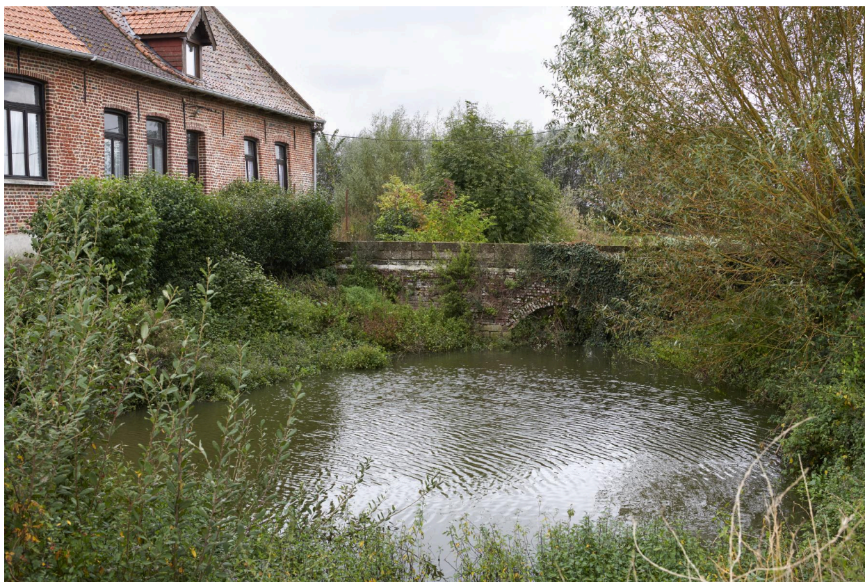
Vue générale du pont de brique.
