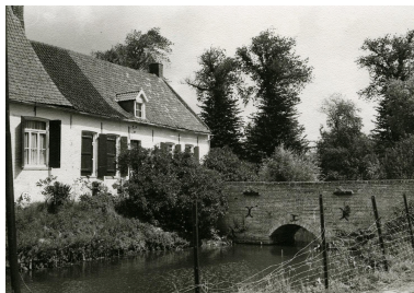
Vue partielle de la façade sud et du ponceau de brique. Août 1974 (coll. Comité Flamand de France). Repro. Delphine Volto Jourdan IVR32_20255900364NUCAB
