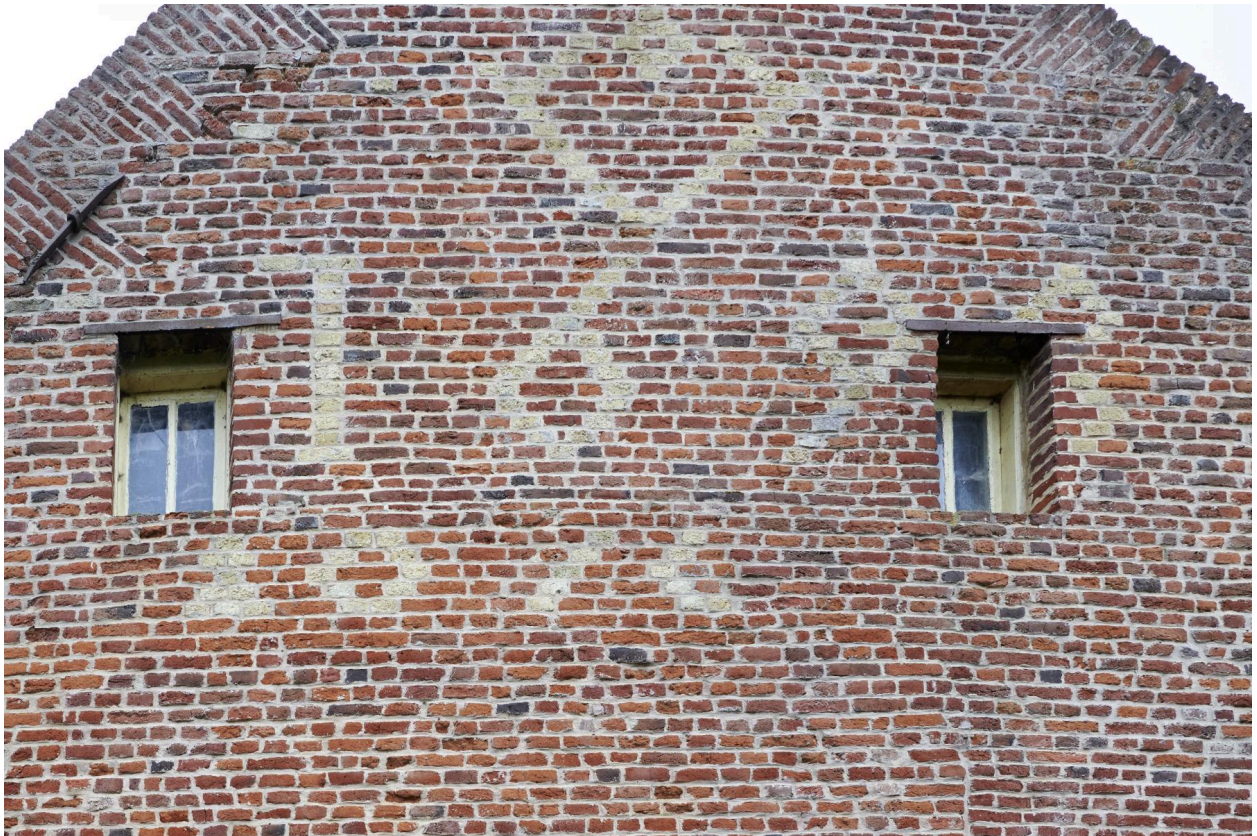
Détail du pignon est.
