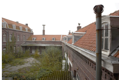
Les combles de la cour ouest. Phot. Pierre Thibaut IVR31_20095903350NUCA
