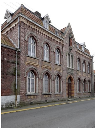
L'entrée principale. Phot. Pierre Thibaut IVR31_20095903372NUCA
