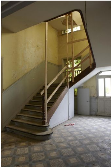
L'escalier de distribution. Phot. Pierre Thibaut IVR31_20095903338NUCA
