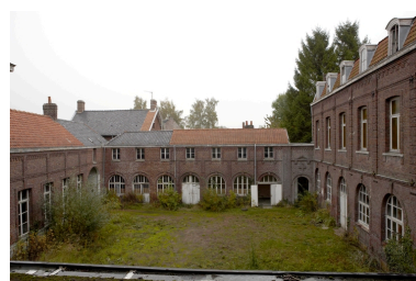
Vue générale de la cour orientale : l'aile sur rue, les communs, l'accès au jardin, l'aile méridionale. Phot. Pierre Thibaut IVR31_20095903351NUCA
