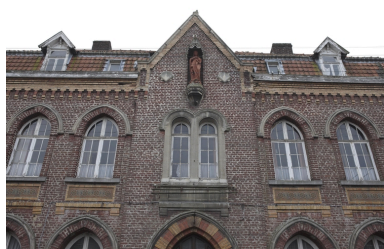
La travée centrale de l'entrée principale. Phot. Pierre Thibaut IVR31_20095903374NUCA
