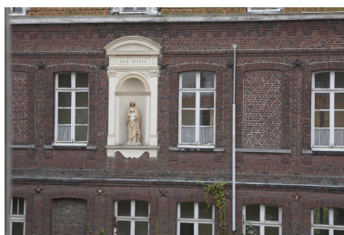
La niche abritant la Vierge, aile nord du bâtiment méridional. Phot. Pierre Thibaut IVR31_20095903347NUCA
