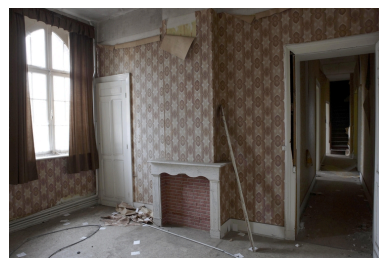
Une des chambres des sœurs supérieures. Phot. Pierre Thibaut IVR31_20095903348NUCA
