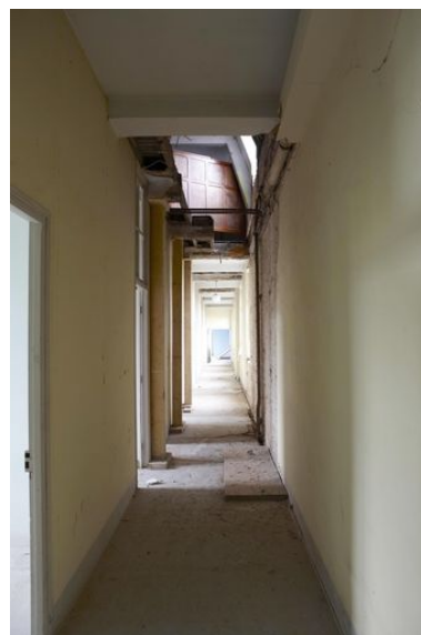
Le couloir desservant les salles de classes du premier étage du bâtiment sud. Phot. Pierre Thibaut IVR31_20095903340NUCA
