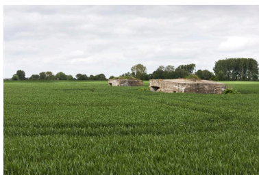
Vue vers l'ouest, des deux casemates d'artillerie. Phot. Jean-Marc Ramette IVR32_20175900160NUCA
