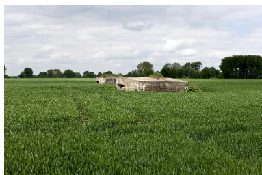
Vue en enfilade, vers l'ouest, des deux casemates d'artillerie. Phot. Jean-Marc Ramette IVR31_20145904742NUCA
