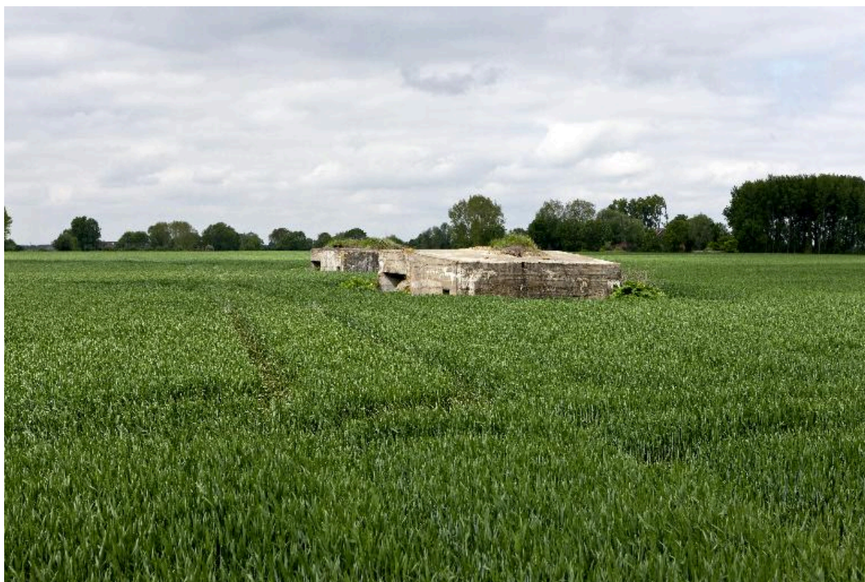
Vue en enfilade, vers l'ouest, des deux casemates d'artillerie.
