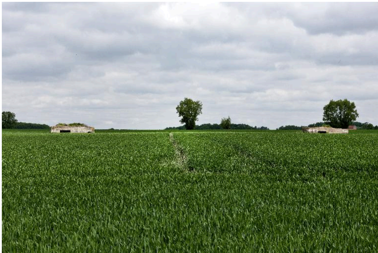
Vue antérieure, vers le nord-ouest, des deux casemates d'artillerie.
