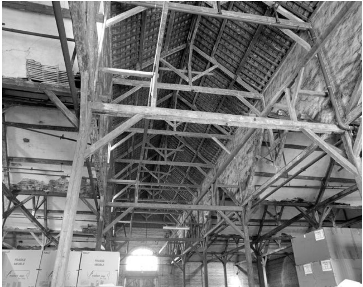
Magasin industriel, en 1989 : vue intérieure (charpente).
