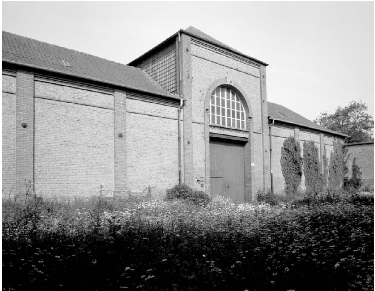
Entrepôt industriel (groupe 1), en 1989 : flanc est.
