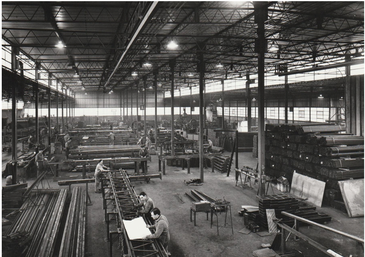
Vue d'ensemble du grand atelier de tôlerie en 1952 (Collection André Protin).
