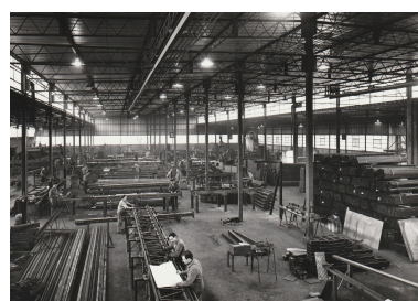
Vue d'ensemble du grand atelier de tôlerie en 1952 (Collection André Protin). Autr. Maurice Barette IVR32_20236005000NUC
