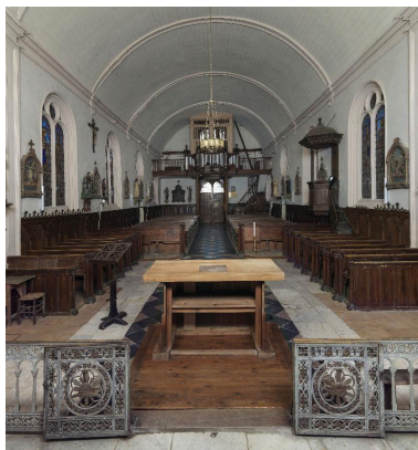
Vue de la nef depuis le chœur.
