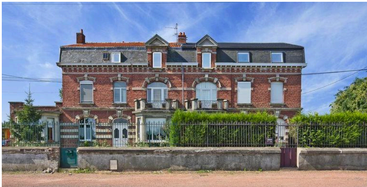
Les anciens logements de directeur de l'usine de la Société des Textiles Chimiques du Nord et de l'Est.
