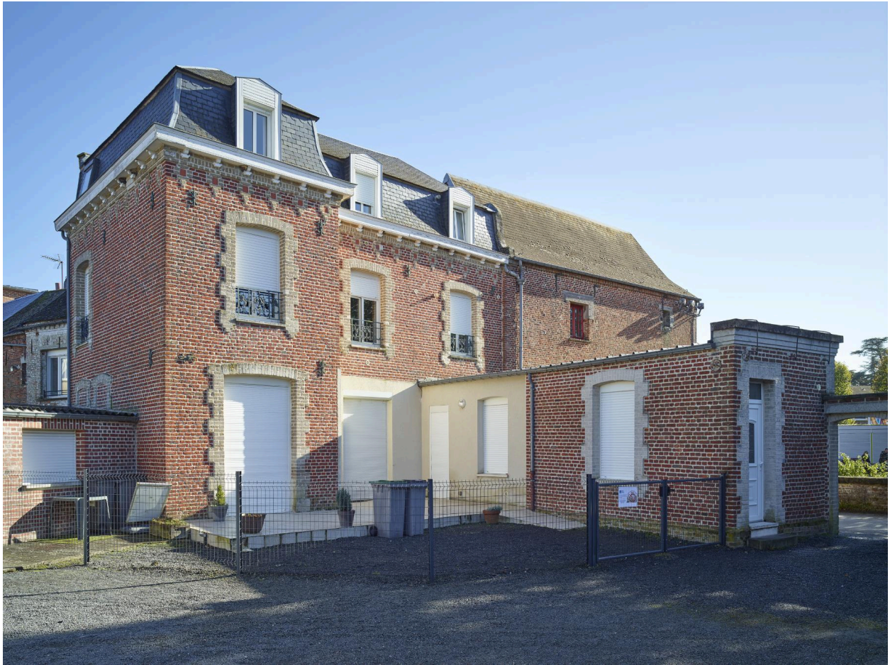
Maison - 50, place du Général-Leclerc : façade arrière.
