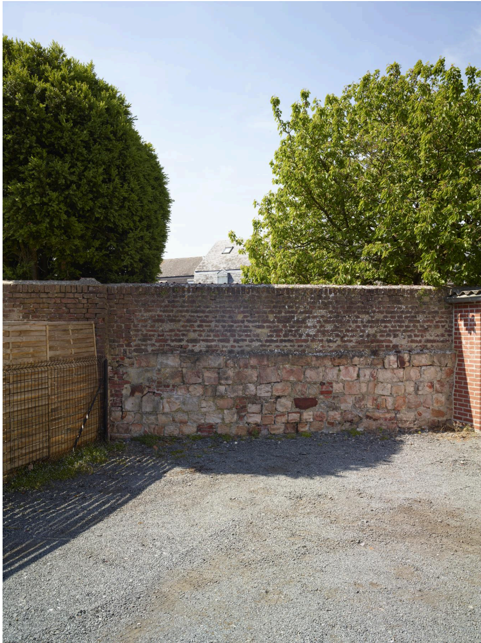
Mur arrière clôturant la cour de la maison du côté des anciens remparts : les moellons de grès de l'ancienne enceinte du château sont visibles dans le bas du mur.
