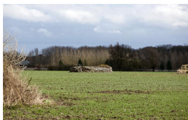
Casemate nord, vers l'est Phot. Jean-Marc Ramette IVR31_20146203037NUCA
