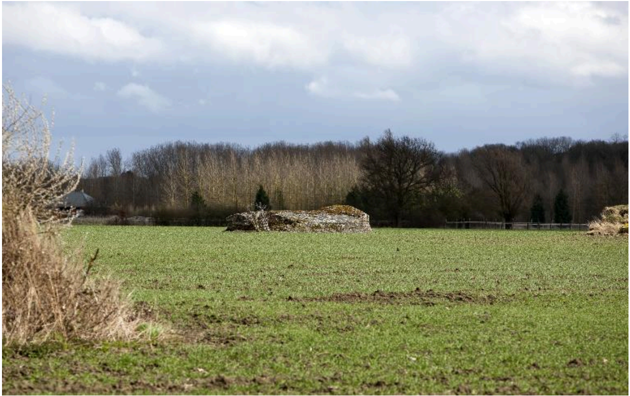
Casemate nord, vers l'est
