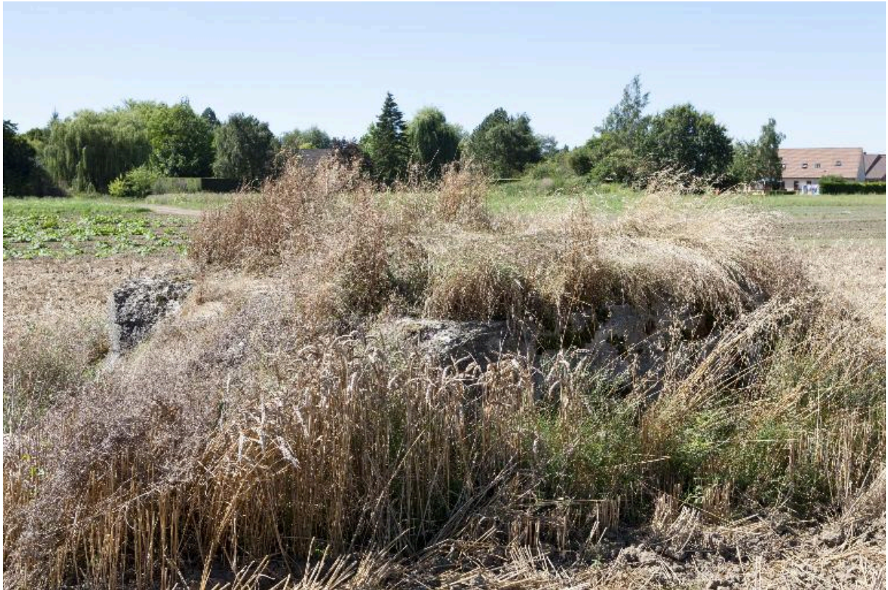
Casemate sud, vers l'ouest
