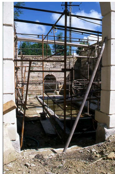
Vue intérieure. Phot. Inès Guérin IVR22_20030203240NUCA
