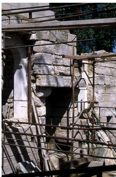
Vue d'un pan de mur en reconstruction. Phot. Inès Guérin IVR22_20030203238NUCA
