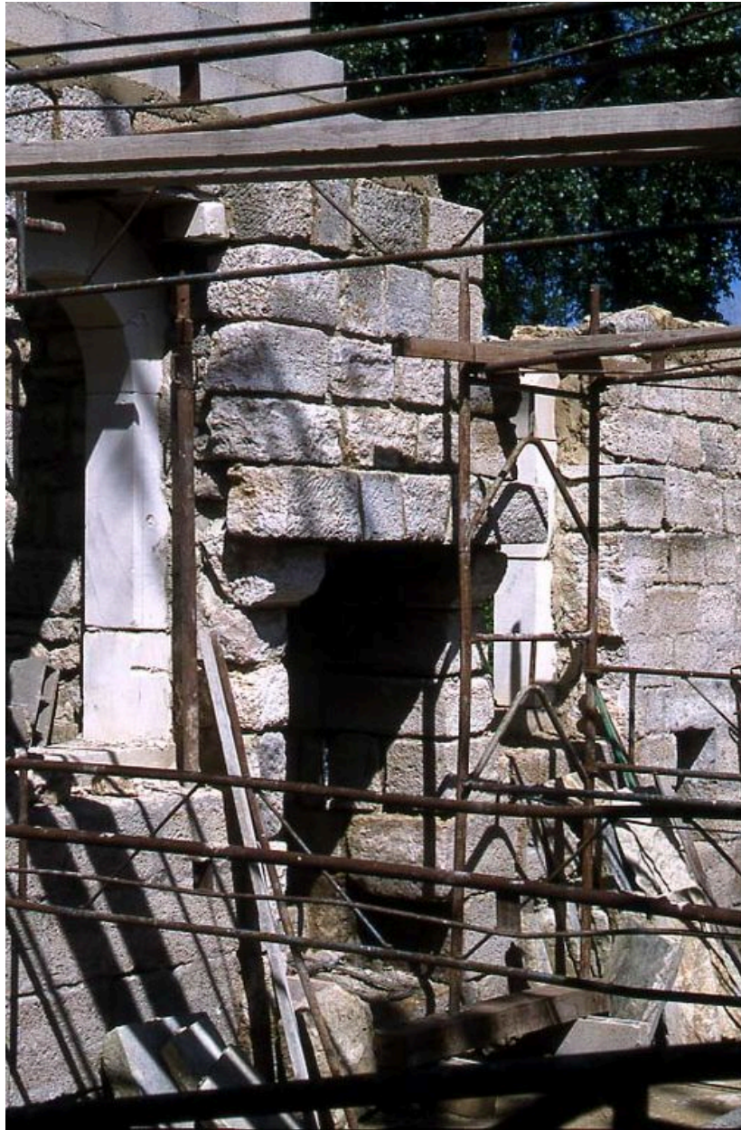
Vue d'un pan de mur en reconstruction.
