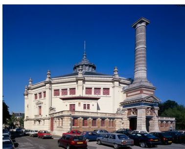
Vue de l'élévation postérieure avec la cheminée. Phot. Irwin Leullier IVR22_19978000855VA
