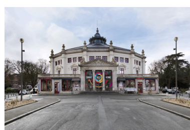
Vue générale depuis le nord. Phot. Thierry Lefébure IVR32_20198000028NUC2A
