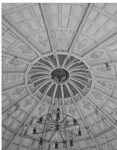
Vue de la partie centrale de la charpente métallique formant verrière. Phot. Thierry Lefébure IVR22_19978000883V
