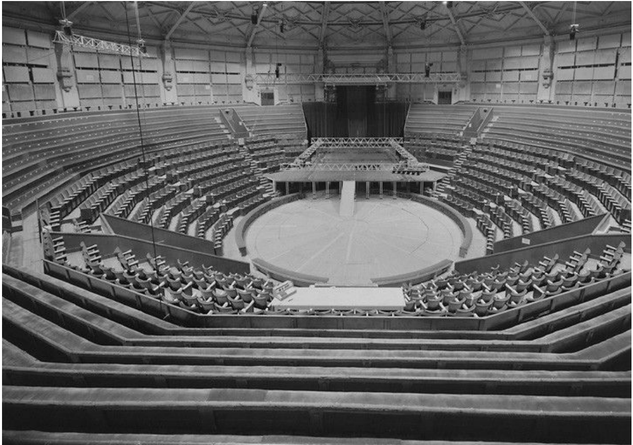
Vue de la salle de spectacle depuis les gradins.
