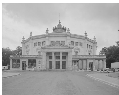
Vue de l'élévation antérieure. Phot. Irwin Leullier IVR22_19978000827V
