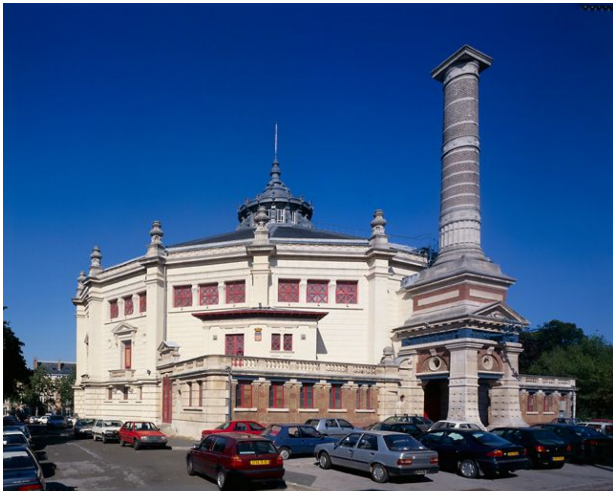
Vue de l'élévation postérieure avec la cheminée.
