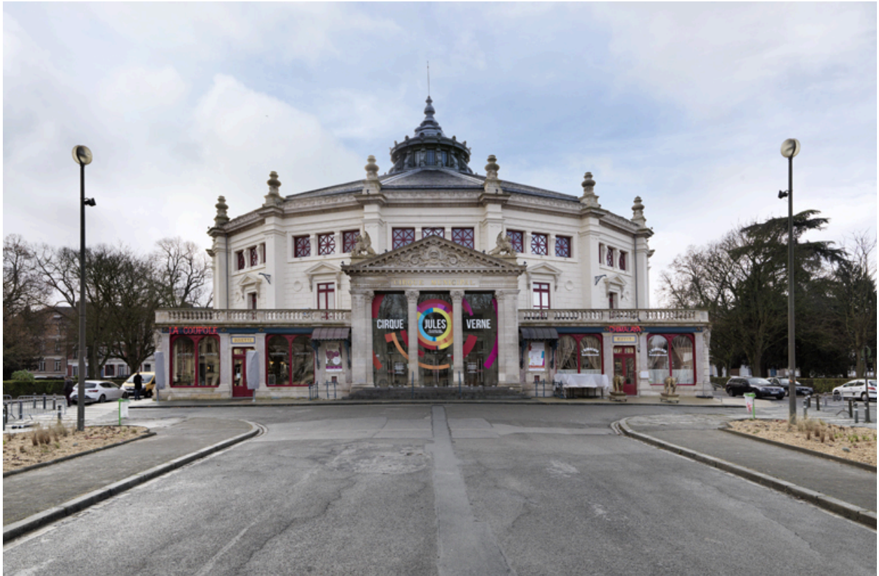
Vue générale depuis le nord.
