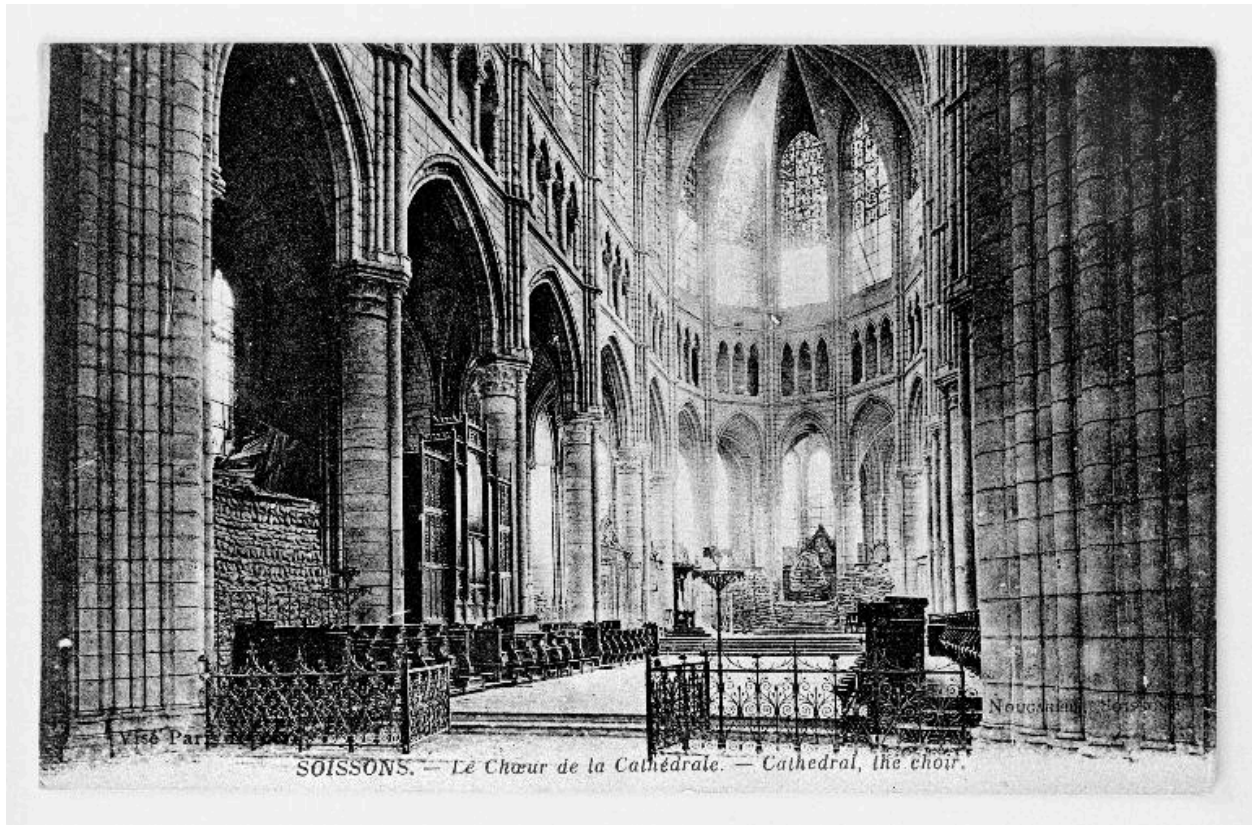
Carte postale montrant l'intérieur du chœur vers 1916 (A Évêché Soissons : 4 Y).
