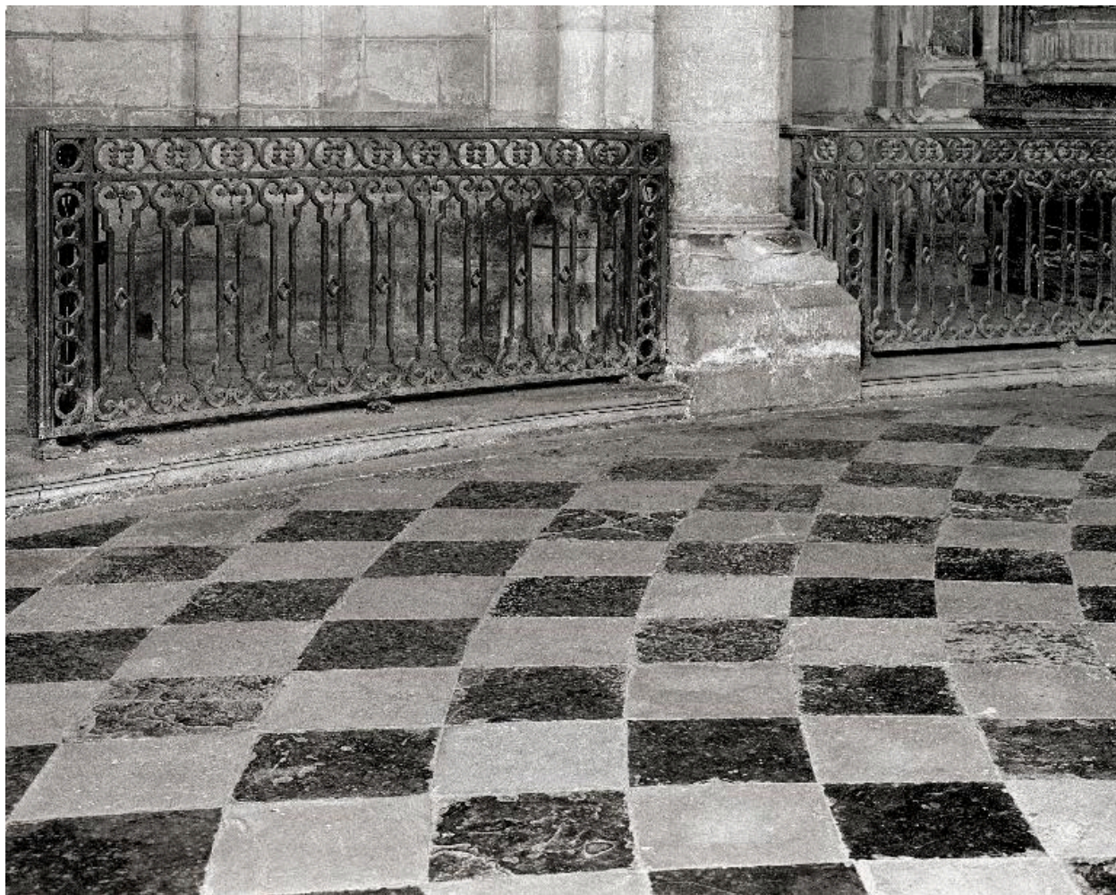
Détail du carrelage de sol du déambulatoire.
