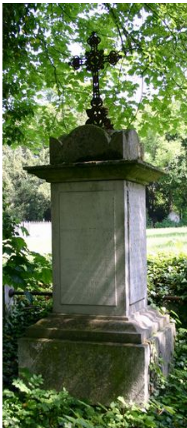
Pilier couronné, surmonté d'une croix en fonte ouvragée. Phot. Caroline Vincent IVR22_20088000608NUCA
