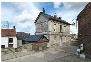
Vue d'ensemble de la façade latérale est, impasse de l'Eglise. Phot. Thierry Lefébure IVR22_20128000605NUC2A
