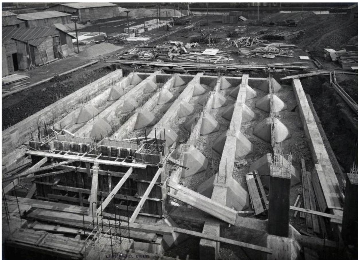
État des travaux le 7 mars 1921. Base des silos en construction.
