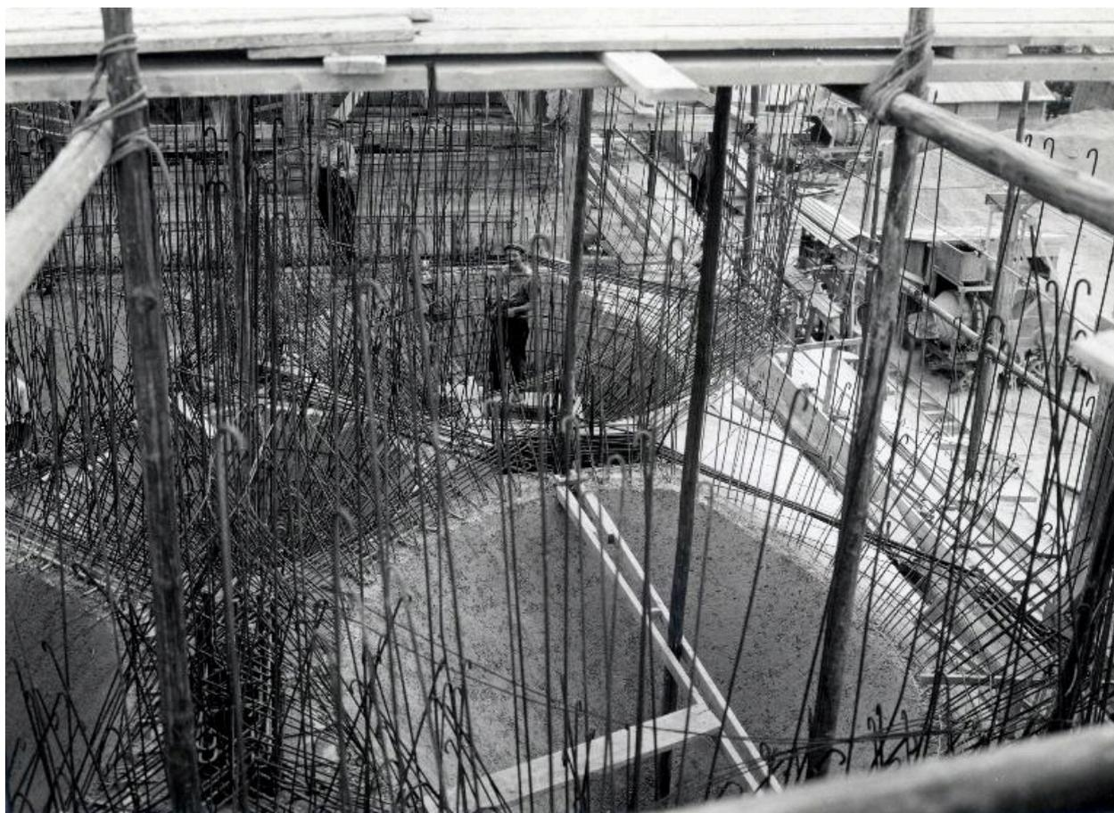
État des travaux le 8 juillet 1921. Ferrailage des silos avant coffrage et bétonnage.
