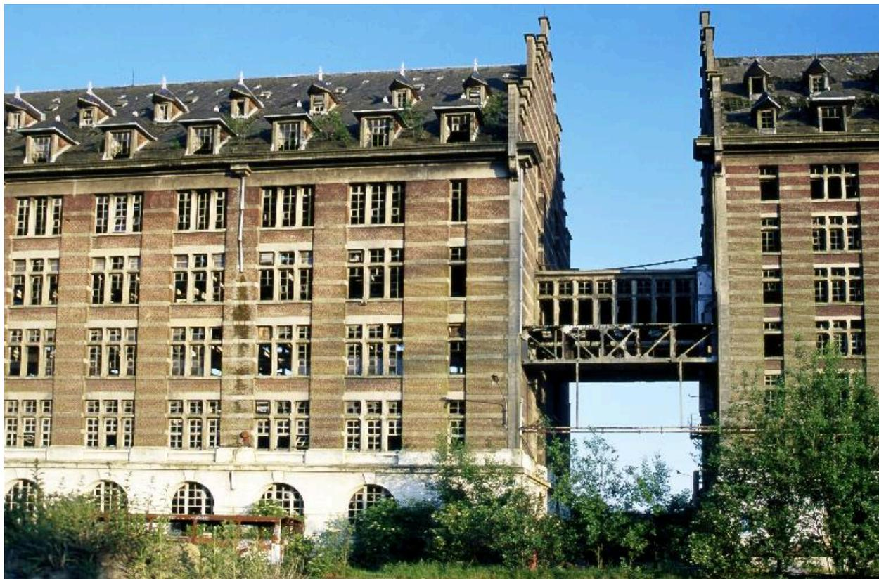
Passerelle au 3e étage reliant la salle des moteurs aux silos à farine, séparés pour raisons de sécurité.
