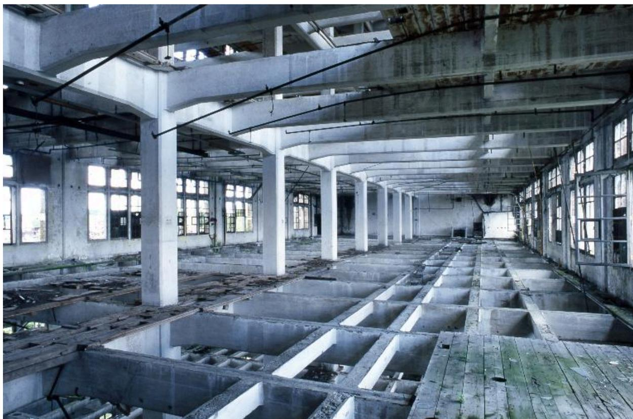
Bâtiment des moulins. Ossature en béton armé.
