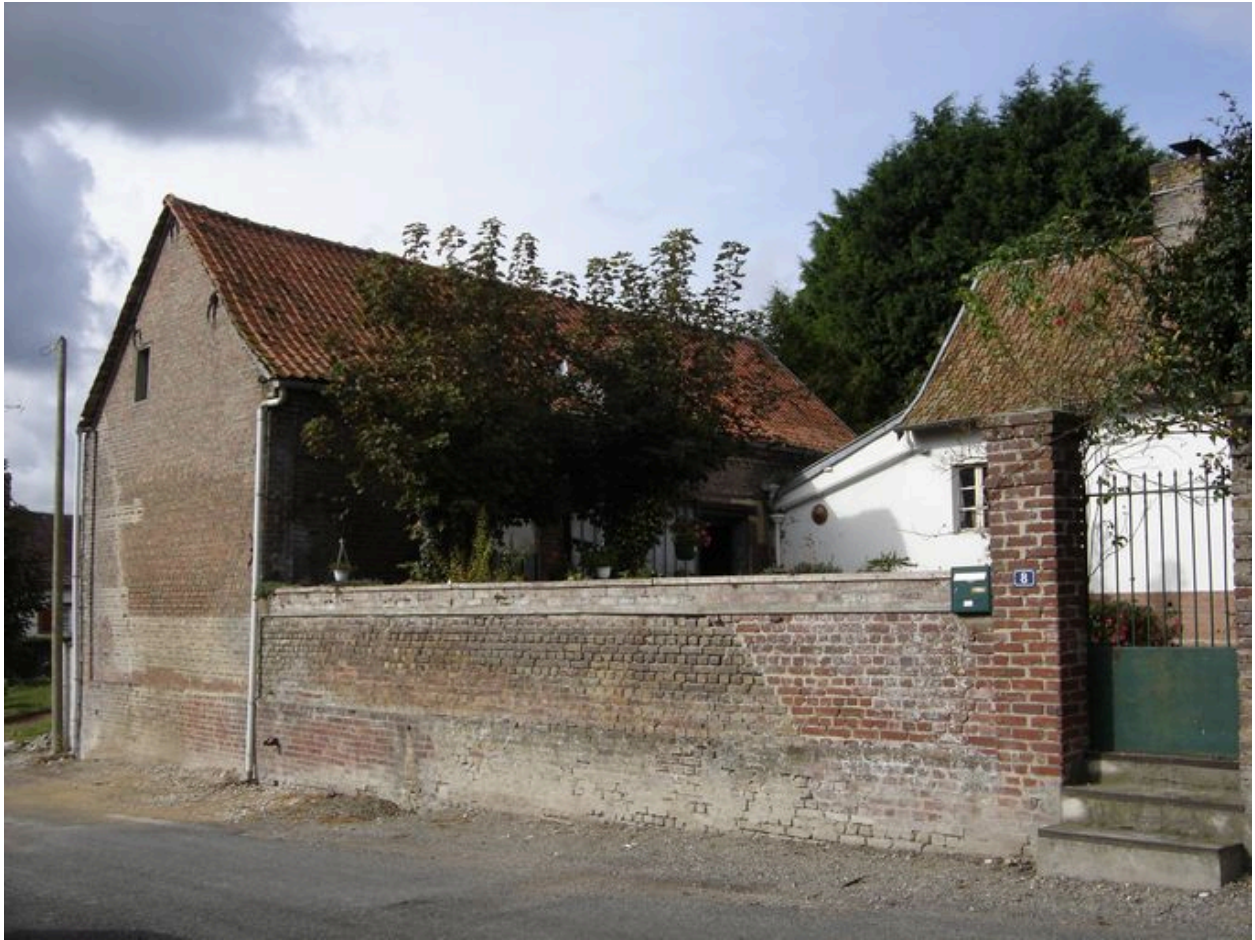
Vue des écuries situées au sud de la cour depuis la rue.
