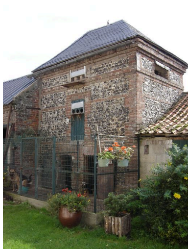
Vue du pigeonnier depuis la cour. Phot. Inès Guérin IVR22_20068005515NUCA
