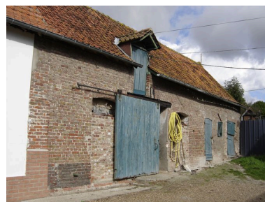
Vue des écuries au nord du logis, dans son prolongement. Phot. Inès Guérin IVR22_20068005511NUCA
