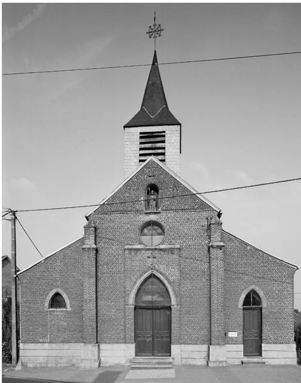
Vue d'ensemble de la façade.
