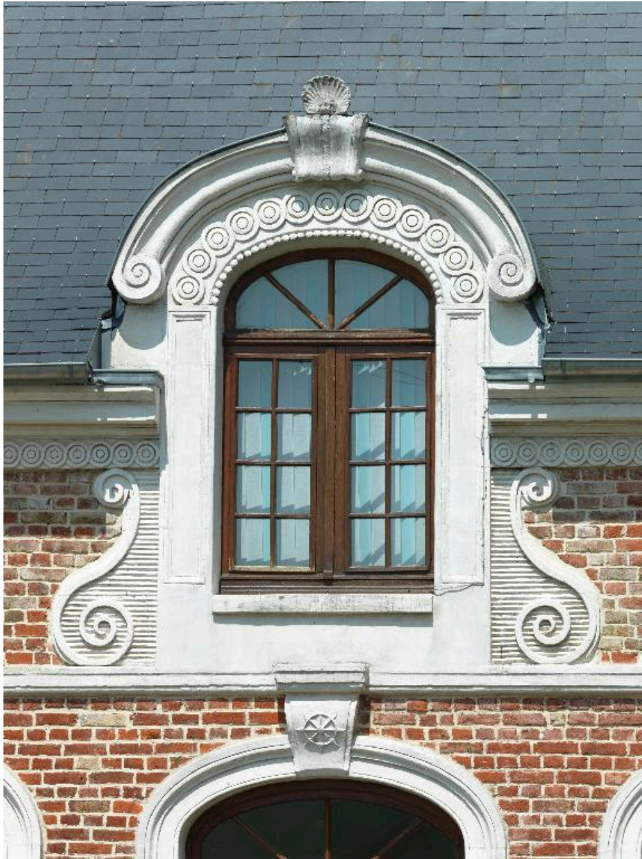
Détail de la lucarne de toit.
