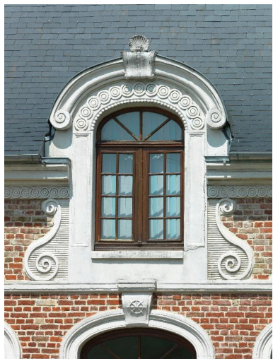
Détail de la lucarne de toit. Phot. Thierry Lefébure IVR22_20128000306NUC2A
