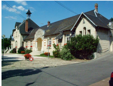
Vue générale. Phot. Frédéric Fournis IVR22_20040203326NUCA
