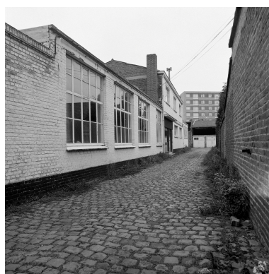
Atelier de fabrication. Vue prise vers le nord-est. Phot. Philippe Dapvril IVR31_19885900853X
