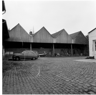
Entrepôts industriels. Phot. Philippe Dapvril IVR31_19885900817X
