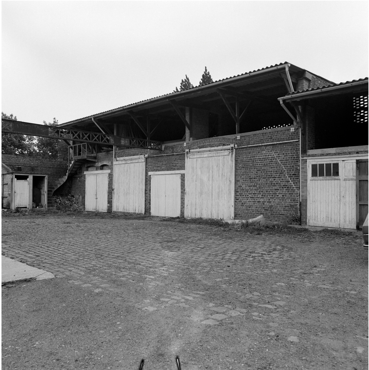
Magasins industriels sur cour.
