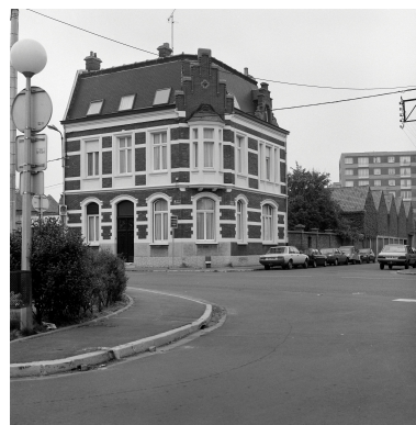
Logement patronal rue du Pont-de-Bois. Phot. Philippe Dapvril IVR31_19885900850X
