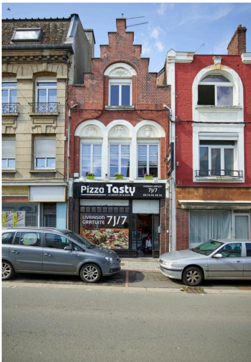
Vue générale de la façade depuis la rue de Péronne.
