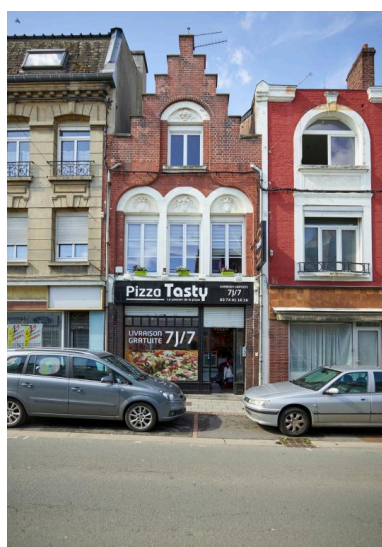
Vue générale de la façade depuis la rue de Péronne. Phot. Hubert Bouvet
