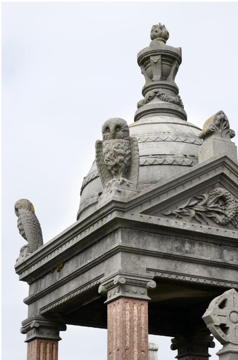
Vue de détail du dôme de la chapelle, d'une chouette et du fronton.
