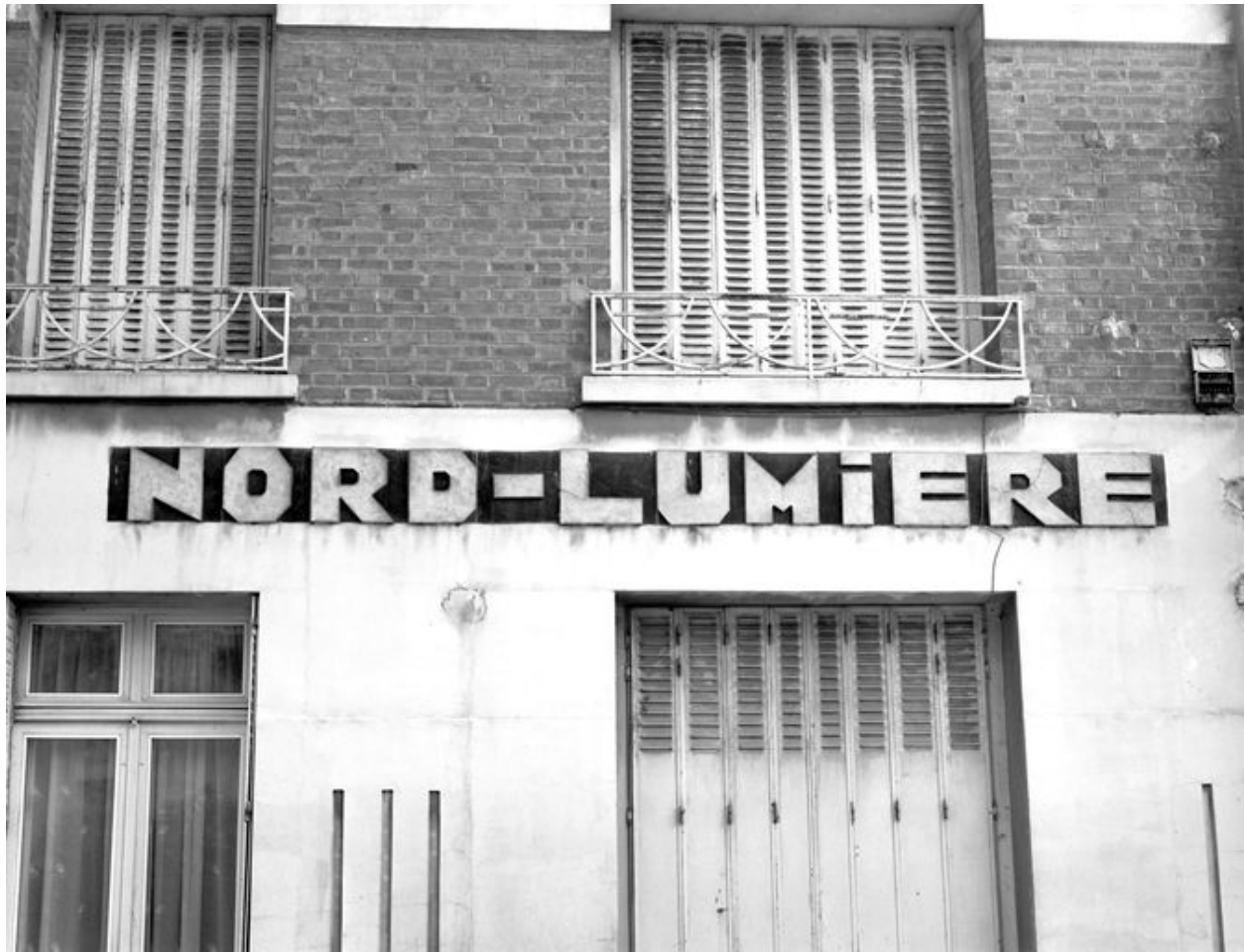
Détail du panneau de grès cérame indiquant la raison sociale du transformateur.
