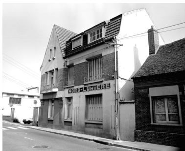
Façade sud du logement donnant directement sur la rue du Faubourg Saint Jean. Phot. Laurent Jumel IVR22_19966002654X
