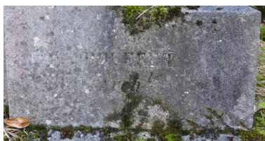
Vue de détail sur la signature de l'architecte. Phot. Isabelle Barbedor IVR32_20168006454NUCA
