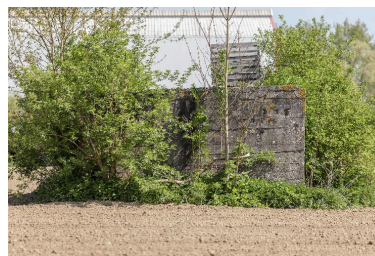
Vue latérale, vers le nord-est Phot. Jean-Marc Ramette IVR31_20145904807NUCA
