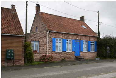
Façade est et pignon sud. Phot. Delphine Volto Jourdan IVR32_20245902954NUCA
