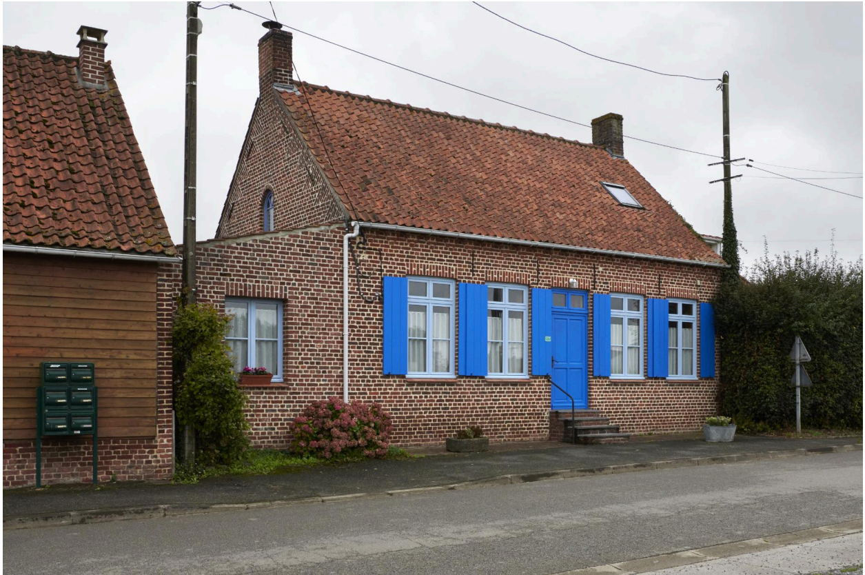
Façade est et pignon sud.
