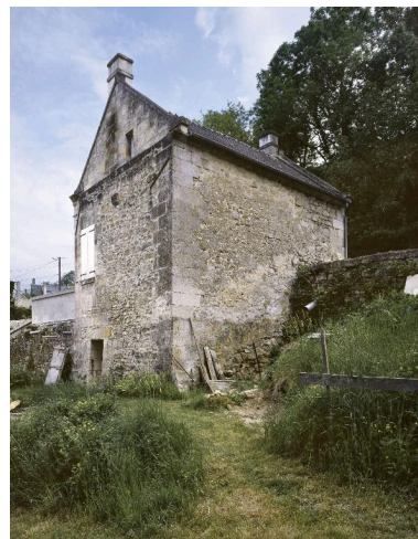
Vue d'ensemble, depuis le nord. Phot. Thierry Lefébure IVR22_19900200866VA
