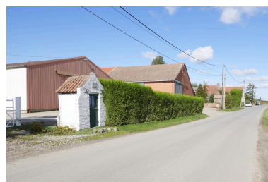
Environnement de la chapelle. Phot. Delphine Volto Jourdan IVR32_20255900627NUCA
