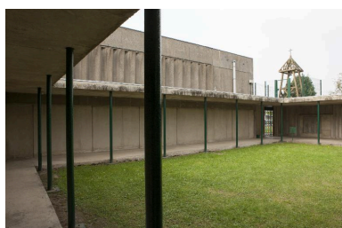
Cloître. Phot. Pierre Thibaut IVR31_20155900178NUCA
