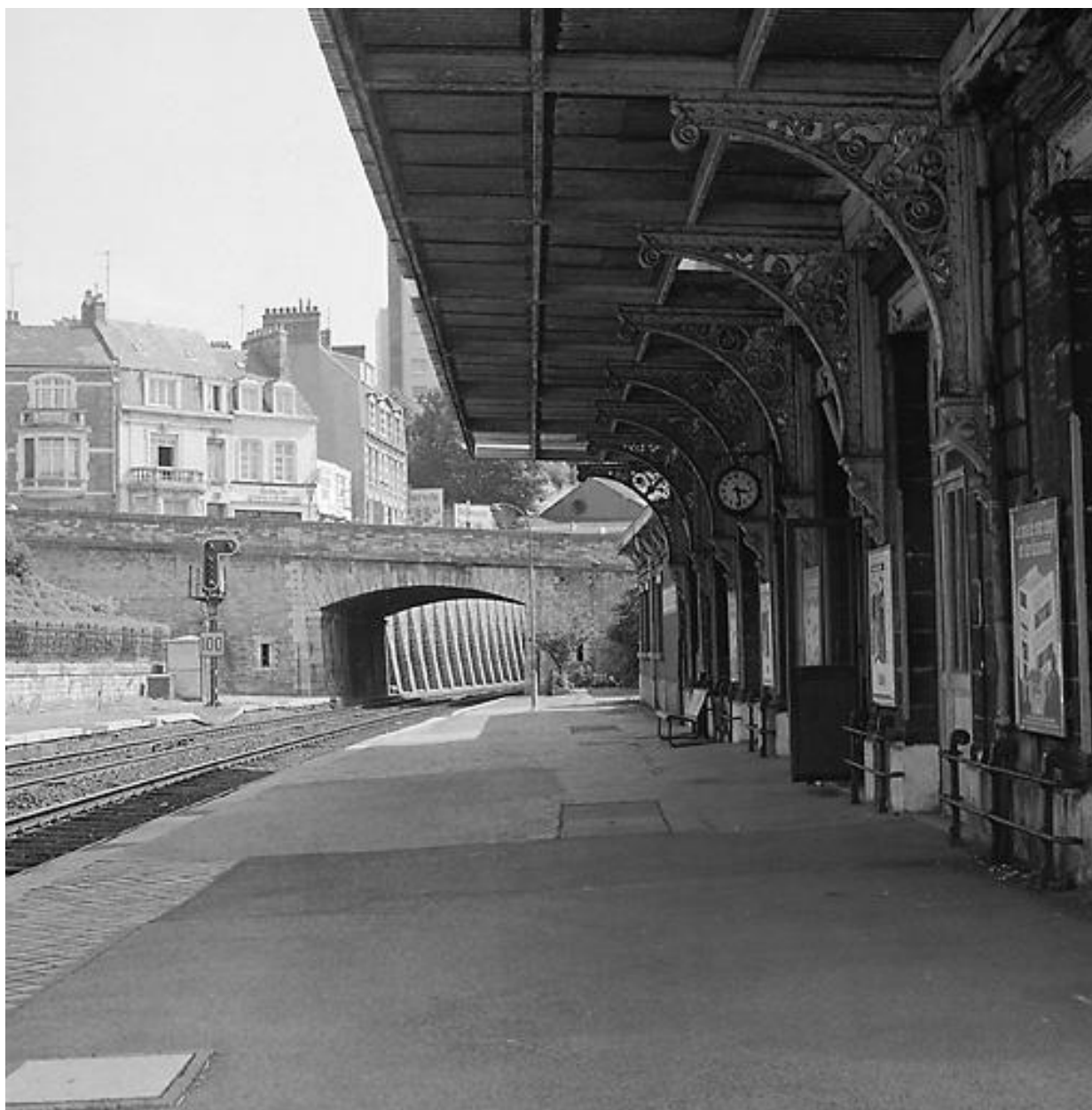
Marquise, sur voie ferrée.
