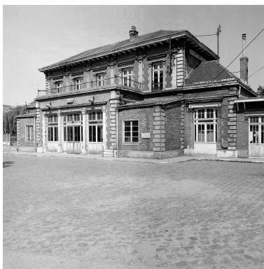
Vue d'angle sur place Zamenhof. Phot. Philippe Dapvril IVR31_19896200713X
