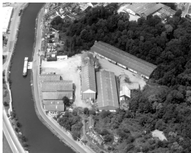
Vue aérienne, flanc est.
