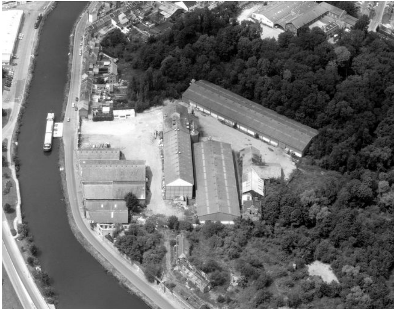
Vue aérienne, flanc est.
