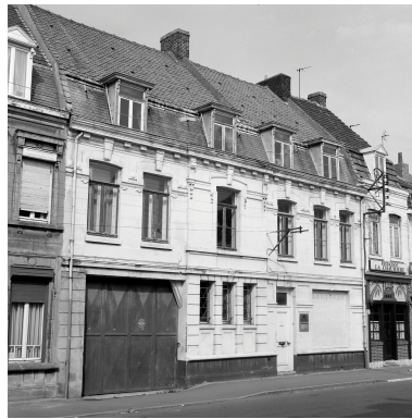
Élévation antérieure rue Jean-Jaures.
