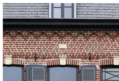
Détail de la date portée et de la corniche. Phot. Delphine Volto Jourdan IVR32_20245903190NUCA
