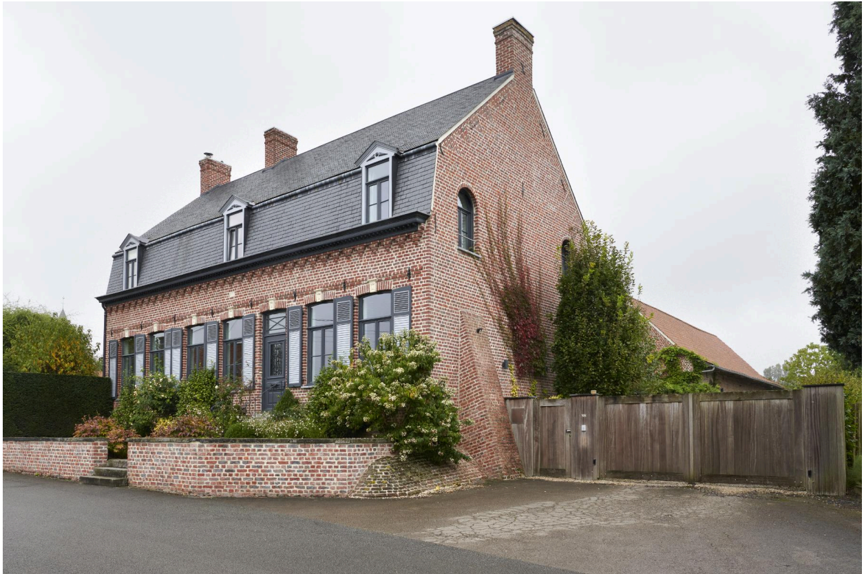
Façade et pignon est.
