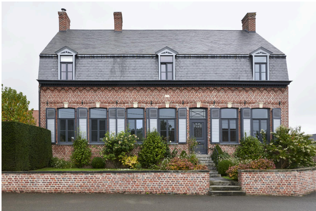
Façade principale sur rue.
