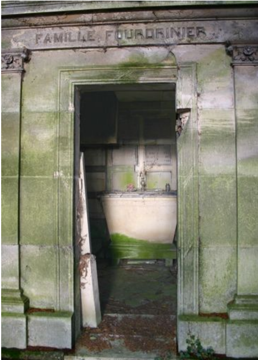
Détail de l'intérieur du tombeau chapelle.
