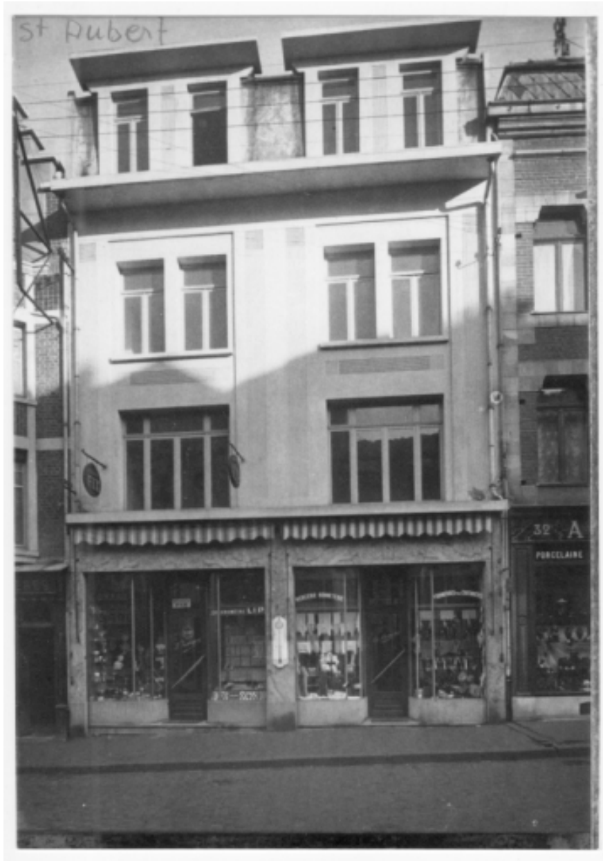
Vue de l'immeuble du 36 rue Saint-Aubert.
