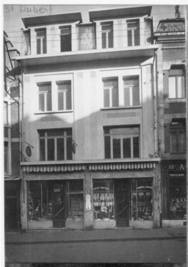
Vue de l'immeuble du 36 rue Saint-Aubert. Phot. Thibaut Pierre (reproduction) IVR31_20096200308NUCB
