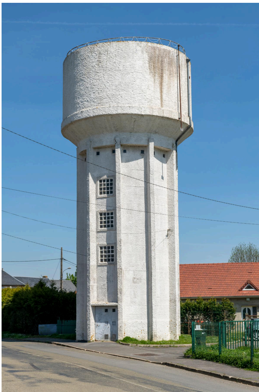
Château d'eau, rue de la Grand Cour.
