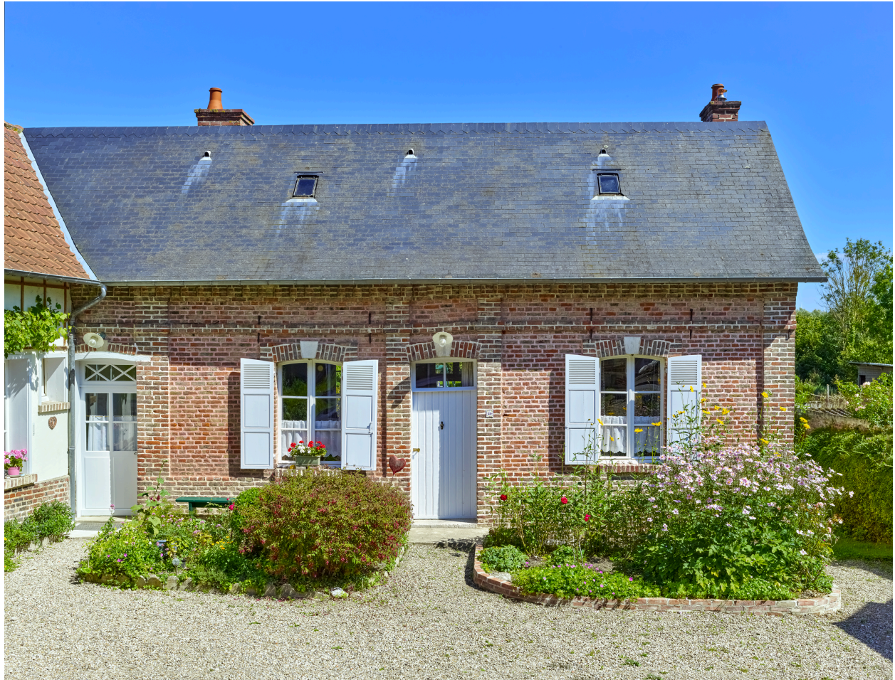
Façade ouest de la maison.
