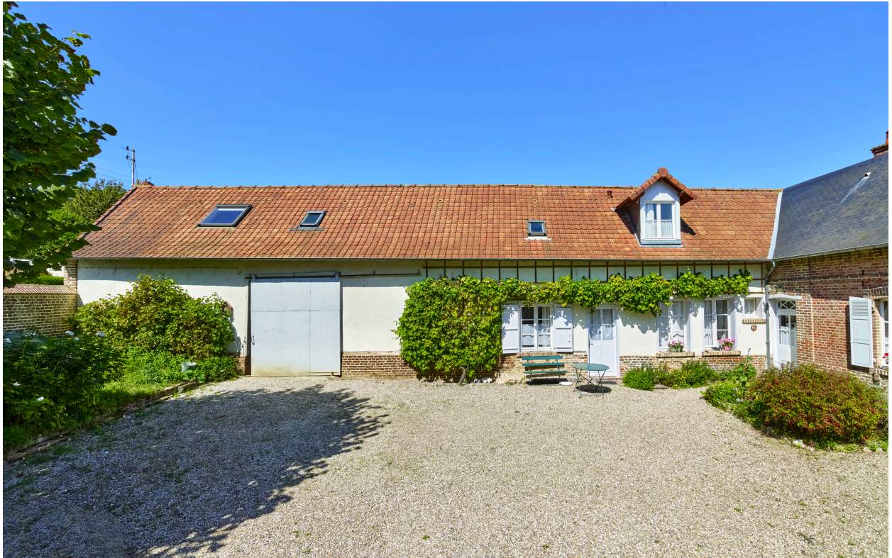
Vue de l'ancien bâtiment agricole, depuis le sud.
