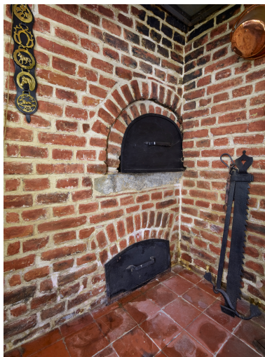
Détail du four à pain de la cheminée. Phot. Thierry Lefébure IVR32_20248001149NUCA
