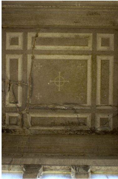
Vue intérieure, détail sur le plafond. Phot. Thierry Lefébure IVR22_20058000013NUCA
