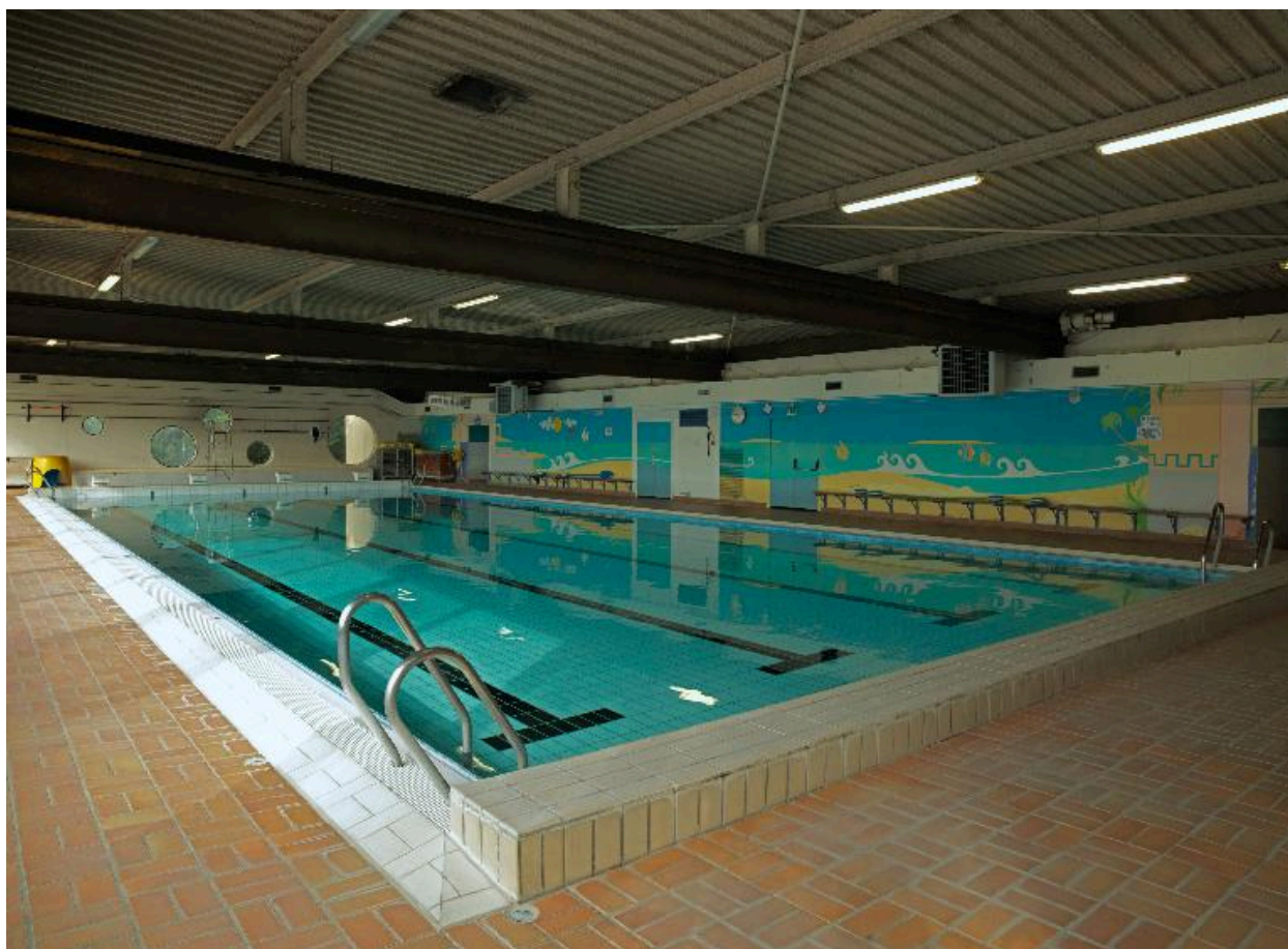
Vue générale du bassin de natation et des poutres de translation permettant l'ouverture de la toiture.
