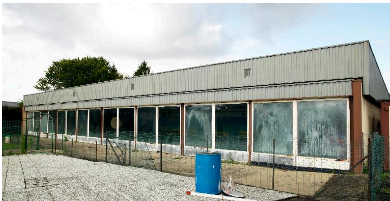
Façade sud et terrasse-solarium.
