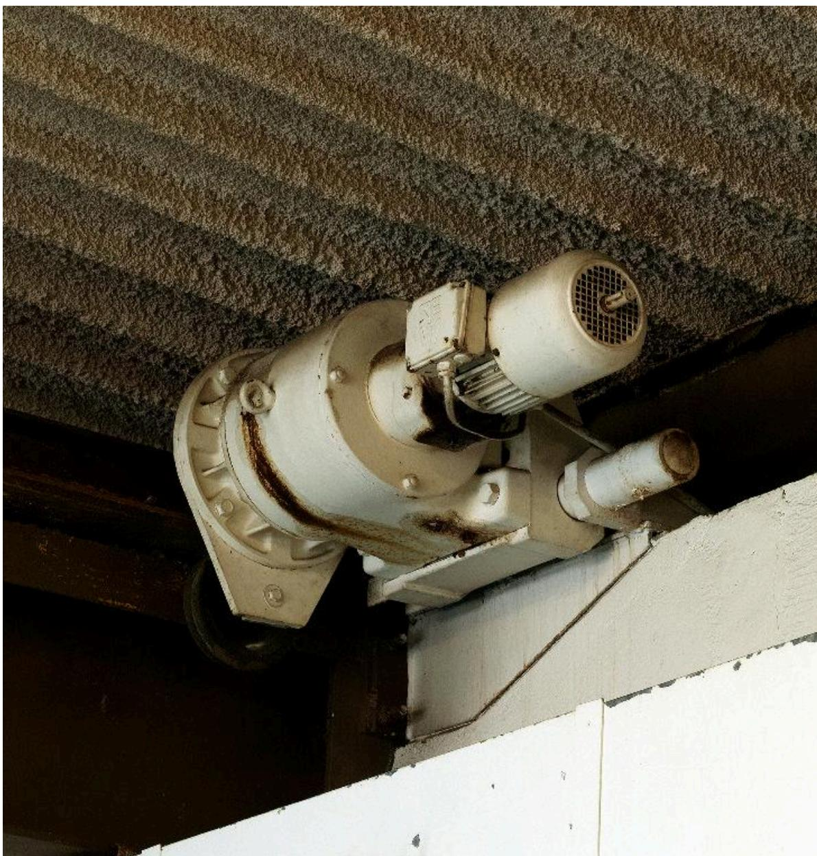
Détail d'un des moteurs actionnant le glissement de la toiture mobile.
