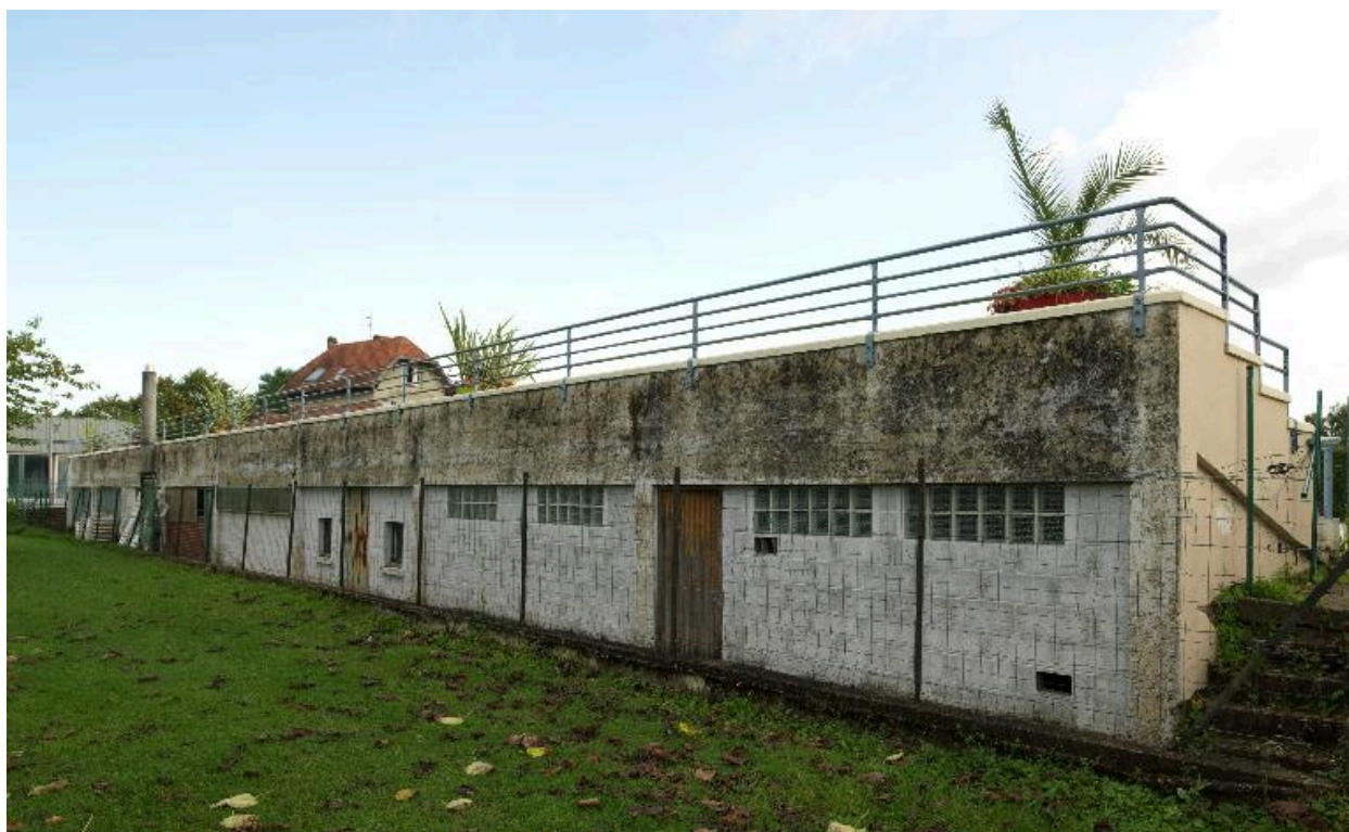
Gradins de l'ancienne piscine découverte, qui abritaient la machinerie et des vestiaires.
