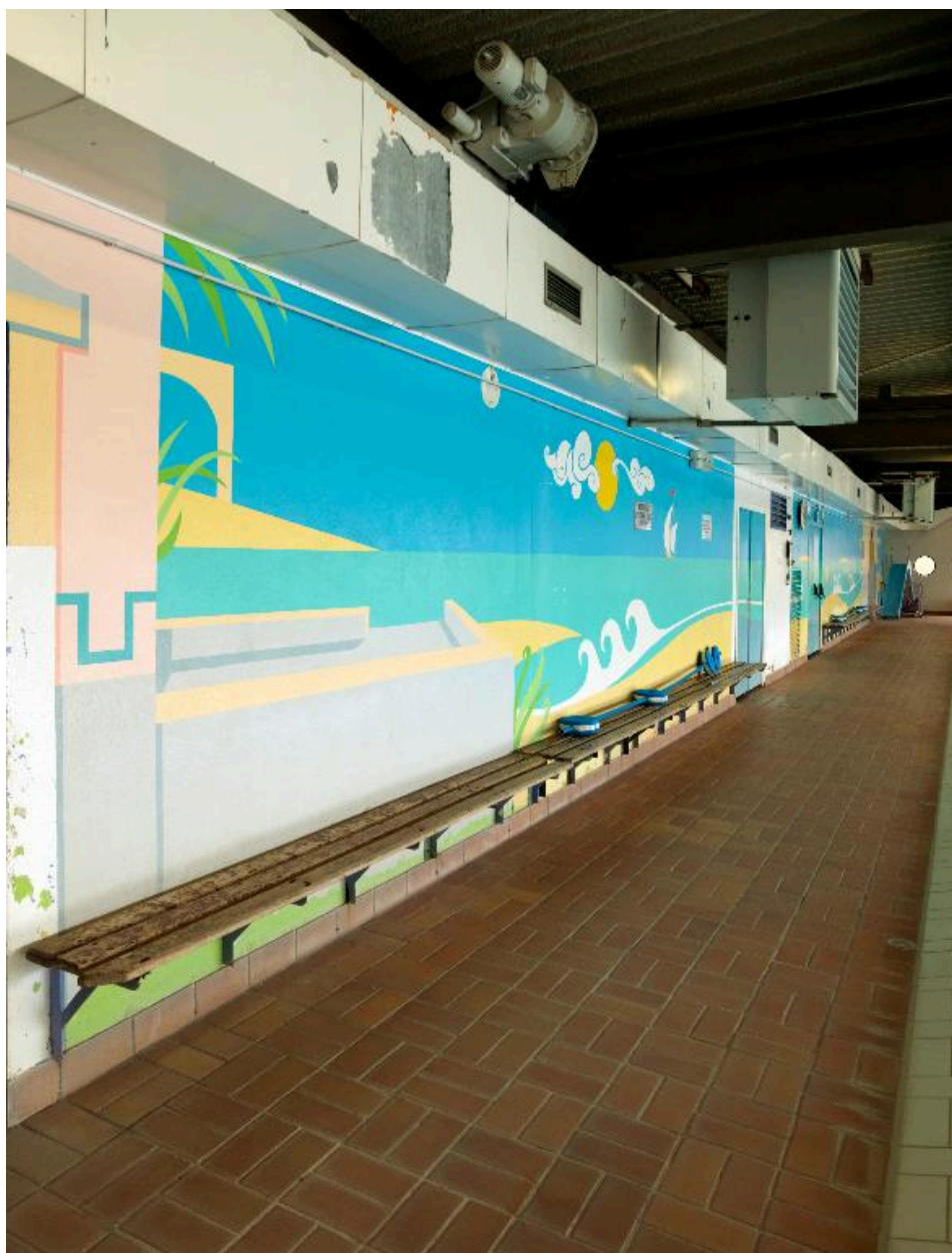
Paroi du hall du bassin, côté vestiaires ; mur longé par un banc en bois (d'origine).
