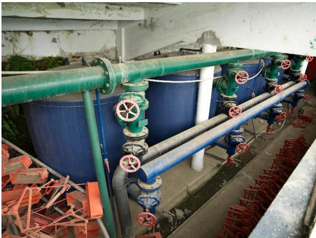
Cuves de filtration de la piscine découverte (sous les gradins).
