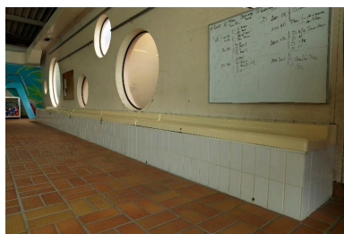
Pignon est, percé de hublots et longé par un banc / coffre à rangement (pas d'origine). Phot. Marie-Laure Monnehay-Vulliet IVR32_20178000435NUC2A
