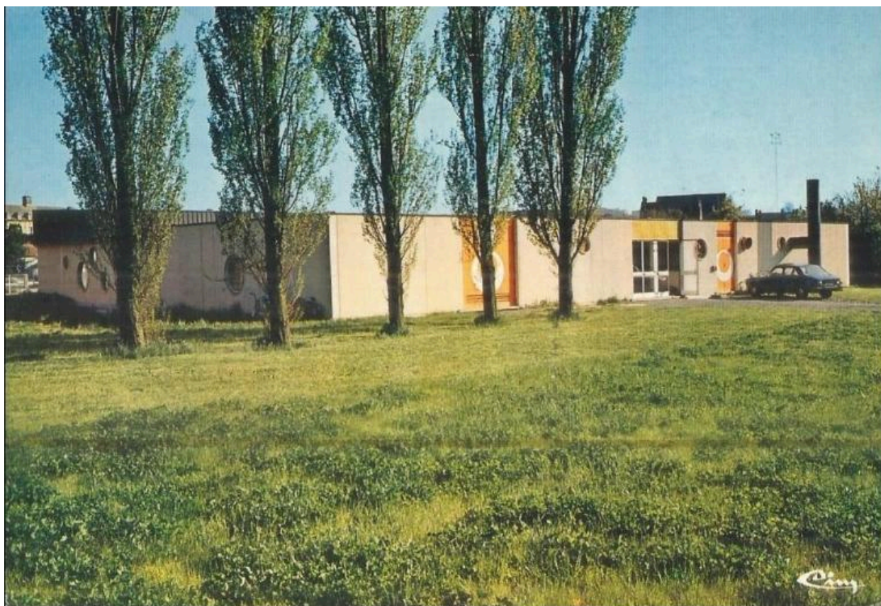
Façade d'entrée de la piscine "Plein Soleil", vers 1980, carte postale (coll. part.).
