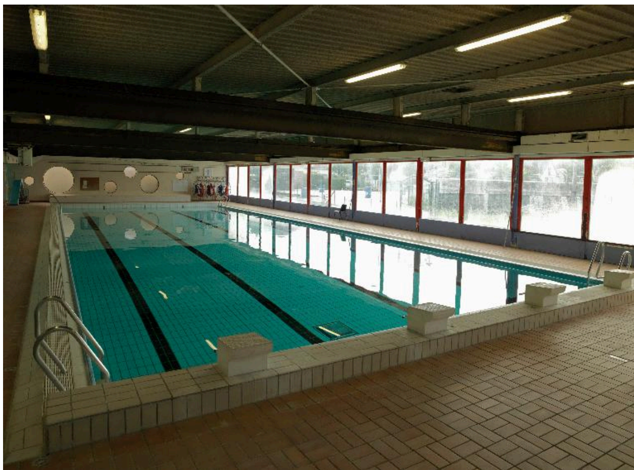
Vue générale du bassin, depuis le côté le plus profond.
