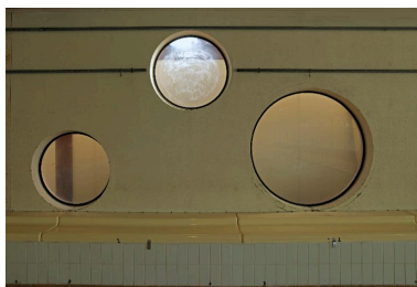
Jeux d'ouvertures circulaires, sur une des façades latérales de la piscine. Phot. Marie-Laure Monnehay-Vulliet IVR32_20178000428NUC2A
