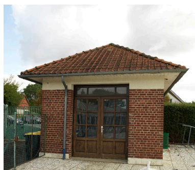
Pavillon d'entrée de l'ancienne piscine découverte. Phot. Marie-Laure Monnehay-Vulliet IVR32_20178000449NUC2A
