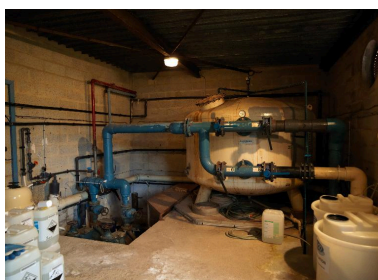
Local technique : filtre à sable "Piscinaro" (d'origine). Phot. Marie-Laure Monnehay-Vulliet IVR32_20178000443NUC2A
