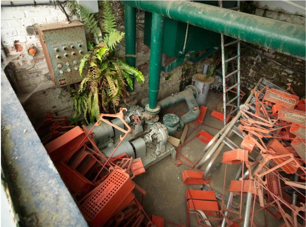
Ancien local technique sous les gradins de l'ancienne piscine : panneau de contrôle, pompes, vannes, tuyauterie et portes-habits.
