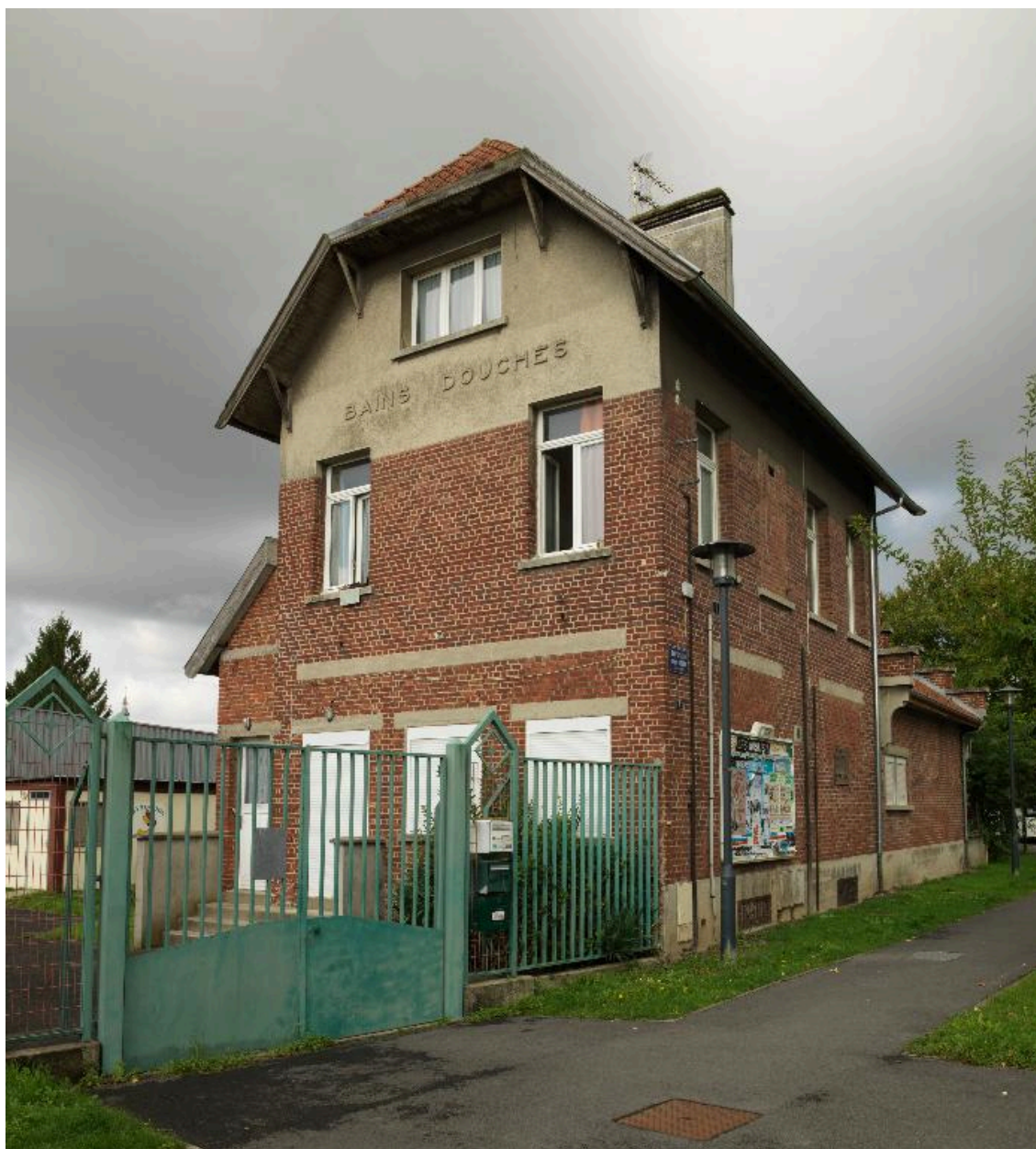
Bâtiment des bains-douches.
