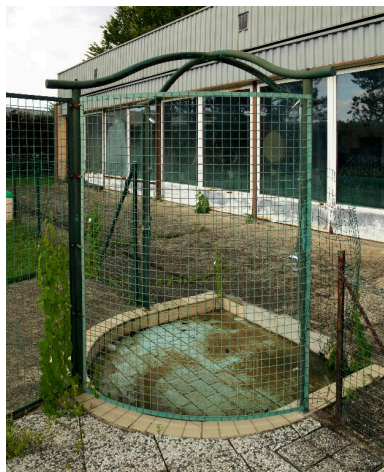
Douche-pédiluve, qui permettait de joindre la piscine Plein Soleil au bassin extérieur. Phot. Marie-Laure Monnehay-Vulliet IVR32_20178000447NUC2A
