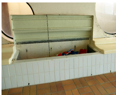
Détail des bancs aménagés le long des murs-pignons, qui servent également de rangement. Phot. Marie-Laure Monnehay-Vulliet IVR32_20178000436NUC2A
