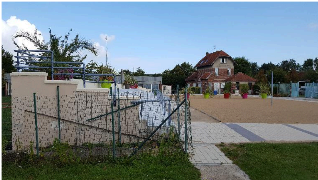
Gradins de l'ancienne piscine.
