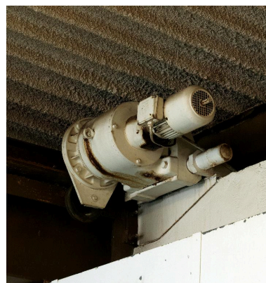
Détail d'un des moteurs actionnant le glissement de la toiture mobile. Phot. Marie-Laure Monnehay-Vulliet IVR32_20178000437NUC2A
