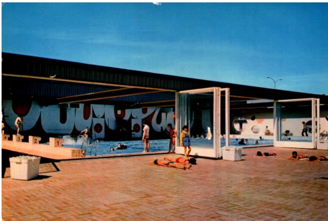
Piscine d'Etampes (Essonne), prototype de la piscine Plein Soleil, carte postale, vers 1975 (coll. part.).
