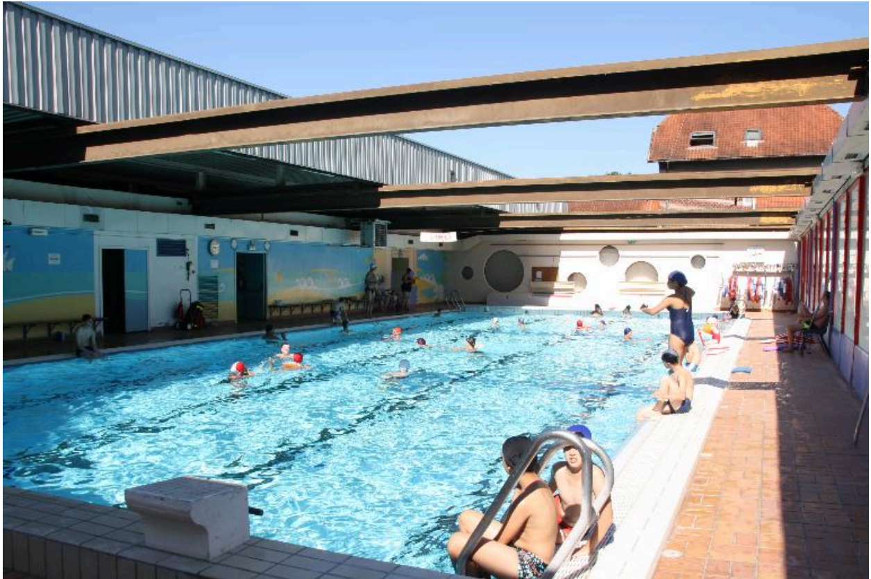
Vue de la piscine en été, avec son toit découvert.
