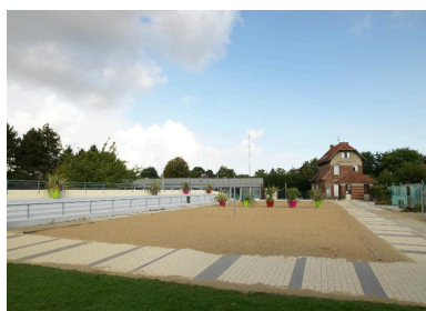
Vue générale des piscines de Doullens : au premier plan, l'ancienne piscine découverte, à l'arrière plan à gauche, façade arrière de la piscine Plein Soleil. Phot. Marie-Laure Monnehay-Vulliet IVR32_20178000453NUC2A
