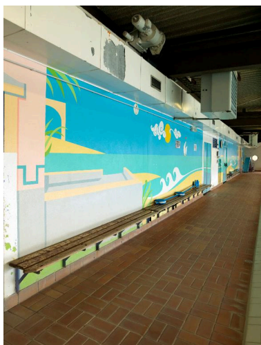
Paroi du hall du bassin, côté vestiaires ; mur longé par un banc en bois (d'origine).
