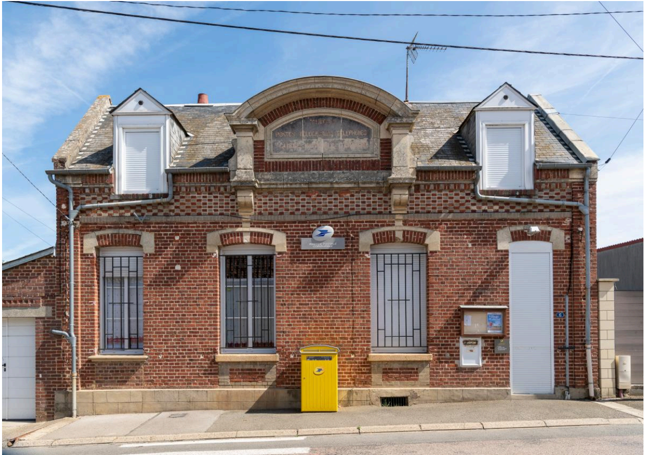
Poste de Thieux, vue depuis le sud.
