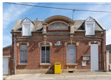
Poste de Thieux, vue depuis le sud. Phot. Marc Kérignard IVR32_20226000383NUCA
