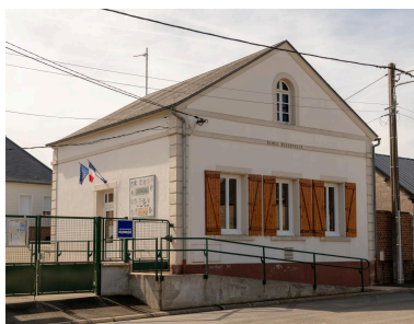
École maternelle, rue de la Ville, vue depuis le nord-ouest. Phot. Marc Kérignard IVR32_20226000380NUCA
