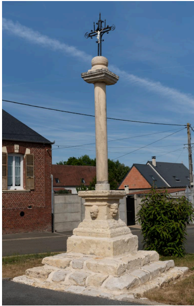
Croix du carrefour de la rue de la Ville et Jeannequin, socle du 17 e siècle, fût et croix remplacés vers 2020, vue depuis l'est. Phot. Marc Kérignard IVR32_20226000379NUCA
