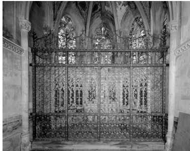
Vue générale, fermée. Phot. Philippe Dapvril IVR31_19946200025V
