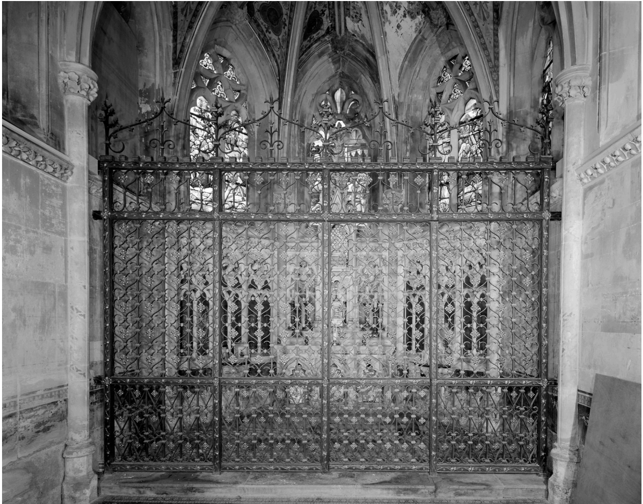
Vue générale, fermée.
