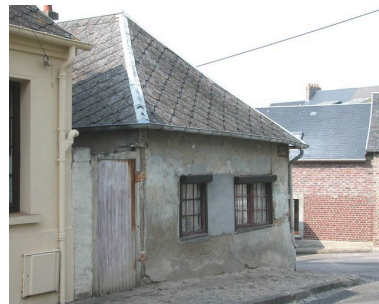
Elévation, rue de la Prairie. Phot. Elisabeth Justome IVR22_20048001675NUCA
