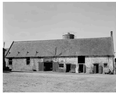
Grange, élévation antérieure. Phot. Jean-Michel Perrin IVR22_19856000577V
