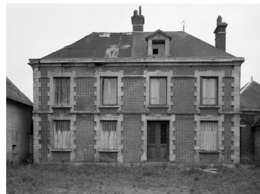
Elévation antérieure. Phot. Jean-Michel Perrin IVR22_19846001157X
