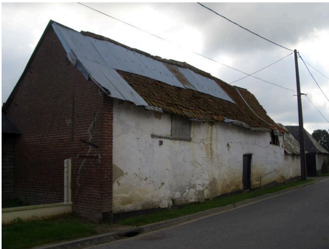
Vue générale de la grange.
