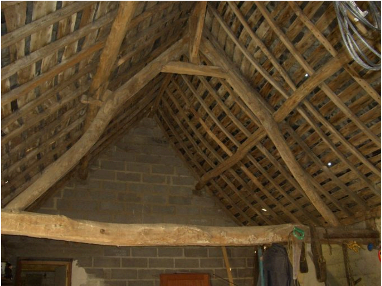
Autre vue d'une ferme de la charpente.
