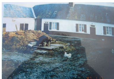
Vue du logis avant les travaux de reconstruction.
