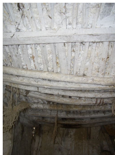
Vue du plafond en torchis badigeonné à la chaux.
