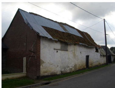
Vue générale de la grange.
