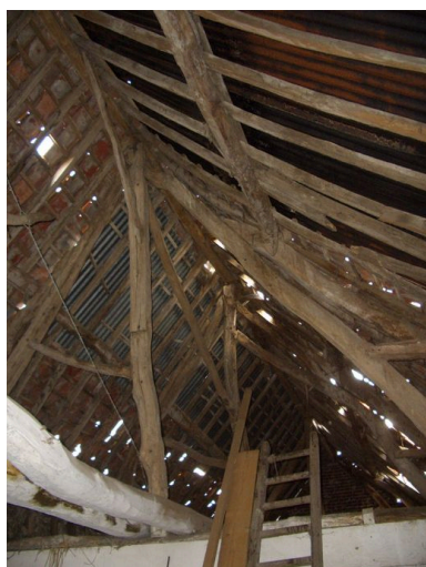
Vue de la charpente.
