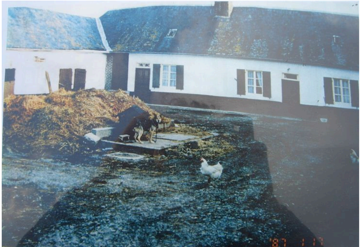
Vue du logis avant les travaux de reconstruction.
