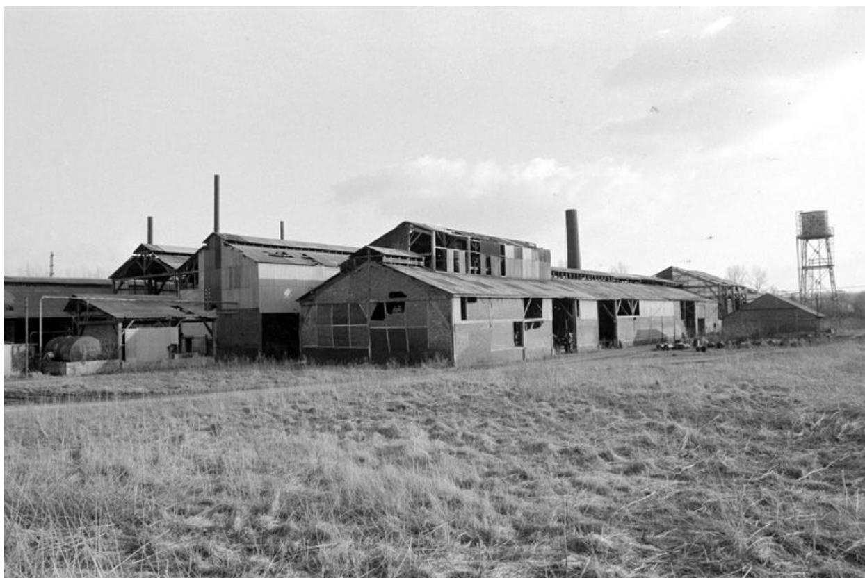
Vue générale, flanc nord.
