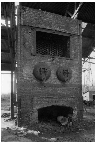
Chaudière à vapeur. Phot. Benoît Dufournier IVR22_19888000291Z
