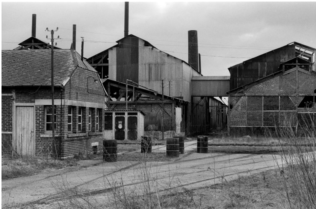
Vue partielle nord-ouest.
