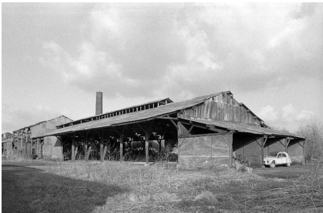
Hangar industriel, flanc sud.
