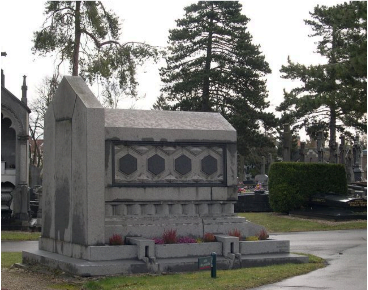
Vue générale depuis le nord-ouest.
